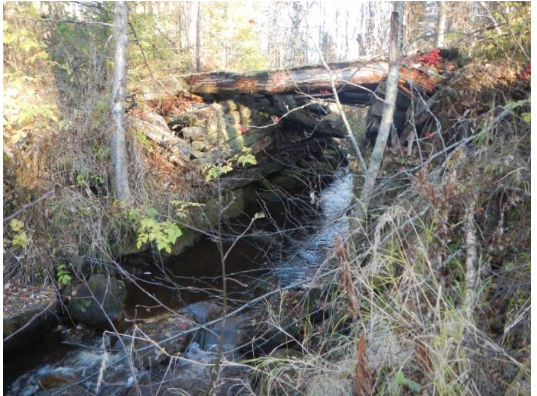
Kuva 28. Kiviperusteisen puusillan jäännökset Hätelän ja Niemelän välillä kulkevan entisen tielinjauksen kohdalla.
