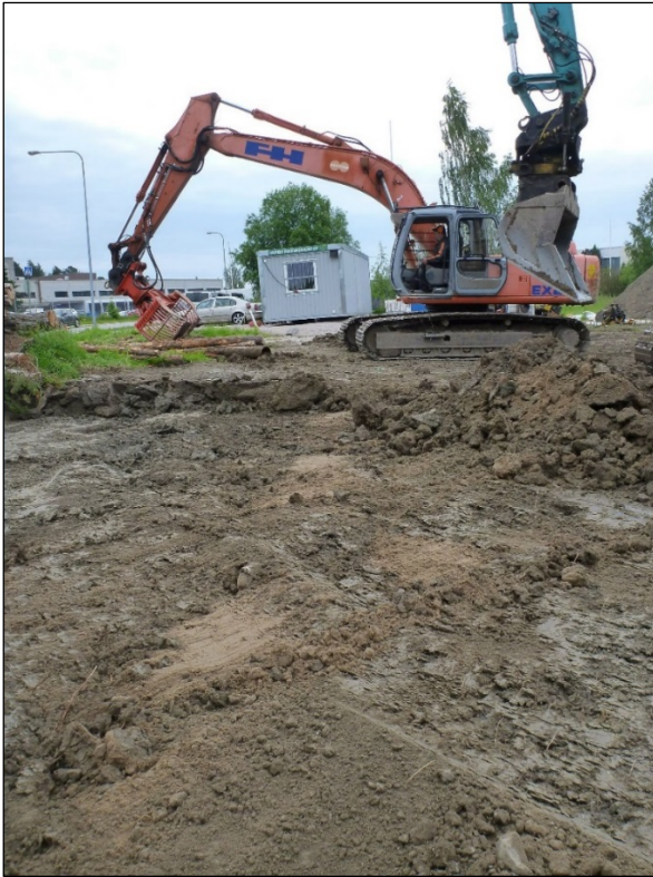
Tutkimusalueen koilliskulmaa kaivetaan. Kuvassa erottuva hiekkamaa on peräisin täytetystä kaukolämpöputken kaivannosta.
