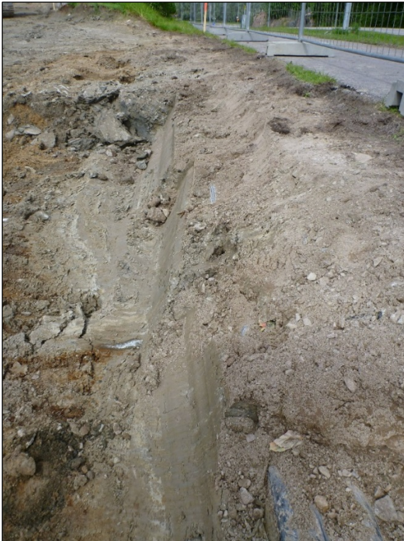
Valvonnassa kaivettua osaa tutkimusalueen pohjoispäässä. Paikalla täyttömaata
