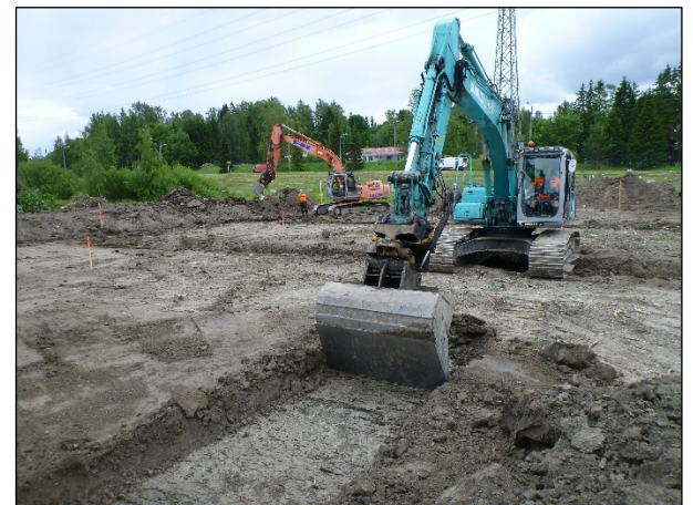
Koekaistaa 5 kaivetaan. Kuvattu kaakkoon.
