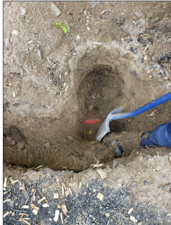
Sähkökaapeleita tutkimusalueella Mäkimiehentien vieressä.
