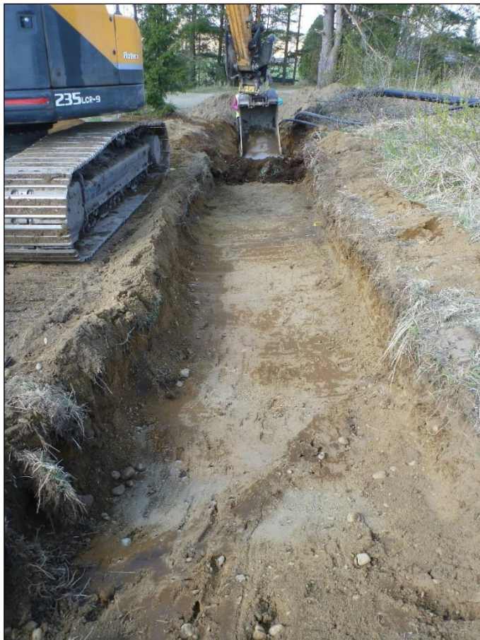
Hiekkamoreeni peltomultakerroksen alla. Kuvattuna länteen.
