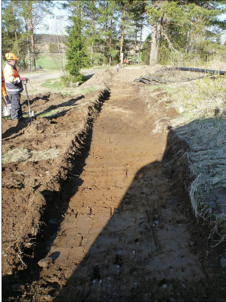
Taso pintamaiden poiston jälkeen. Kuvattu länteen.
