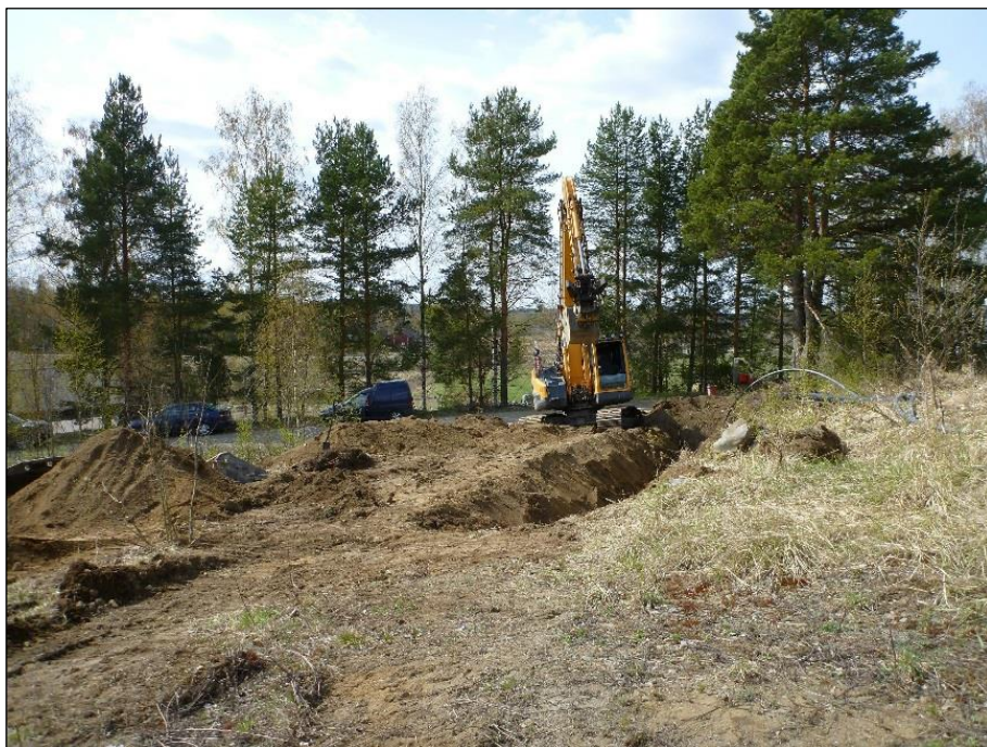
Kaivantotyömaa kuvattuna länteen.
