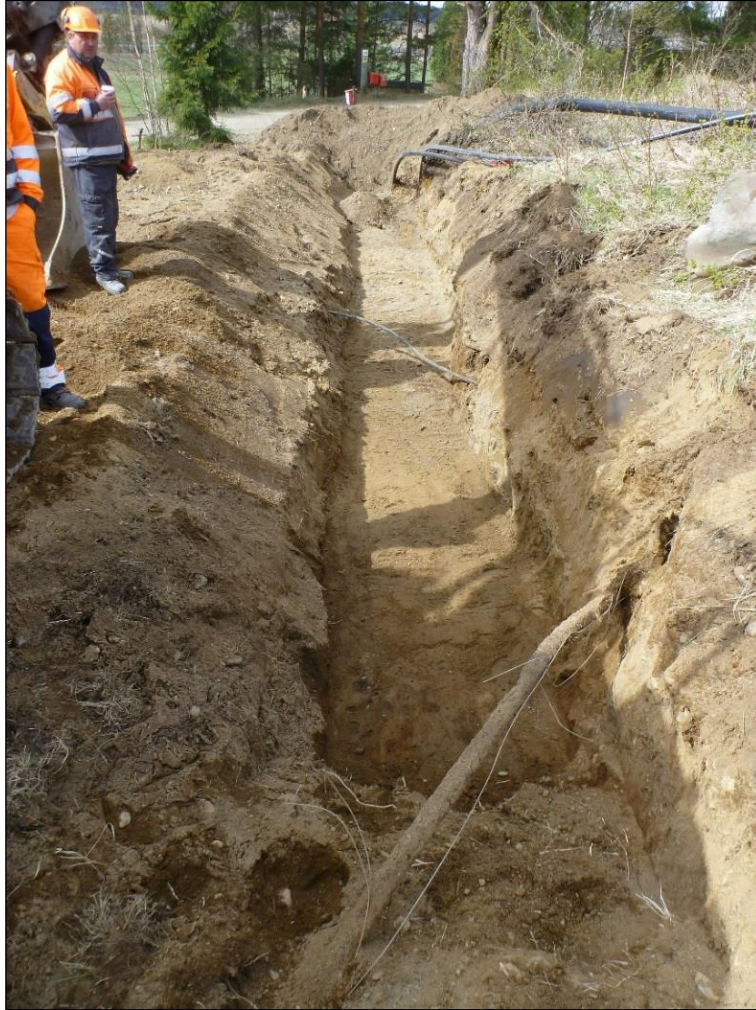
Kaivantoa kuvattuna länteen. Aikaisemmin kaivetut kaivannon poikki kulkevat vesijohto, selkä kaapeli näkyvillä.
