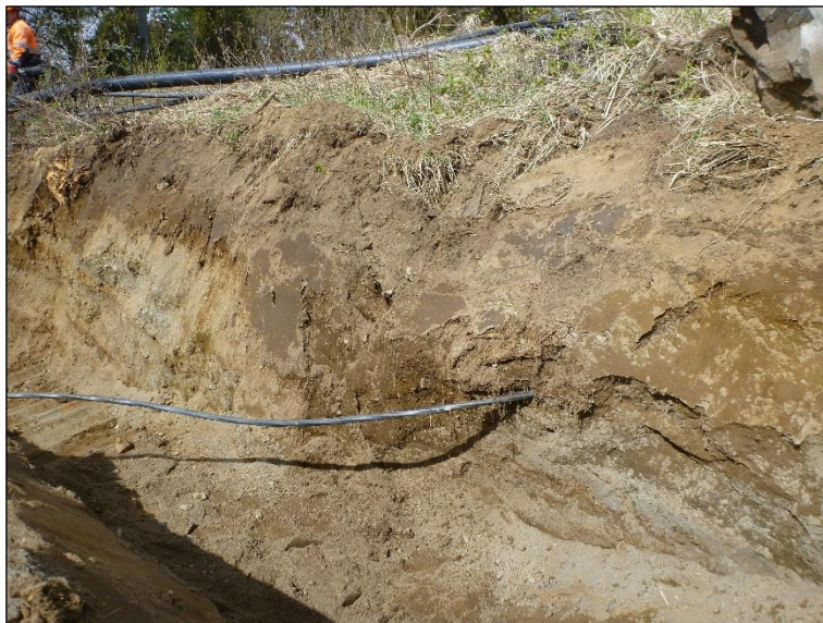
Kaivannon pohjoisprofiilia kaivannon poikki menevä aikaisemmin kaivettu kaapeli esillä.
