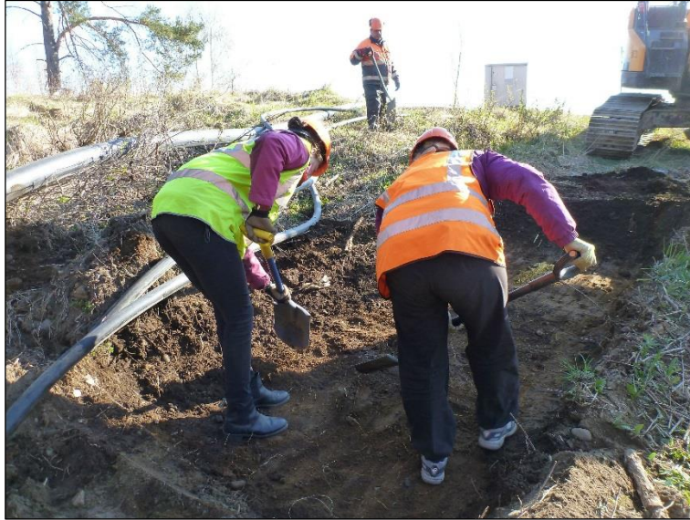
Paljastunutta tasoa tutkitaan lapiolla kaivamalla, ennen koneellisen kaivamisen jatkamista.
