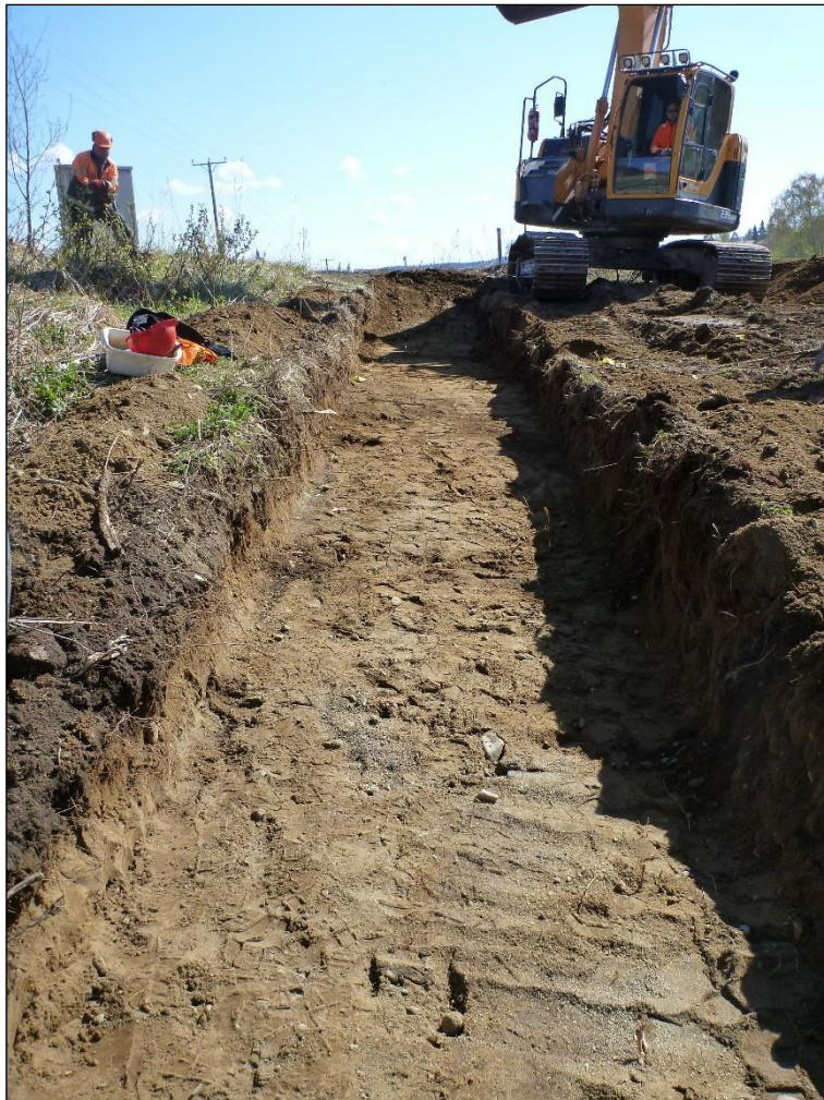
Valvonnassa kaivettua ja tutkittua linjaa. Kuvattuna itään.
