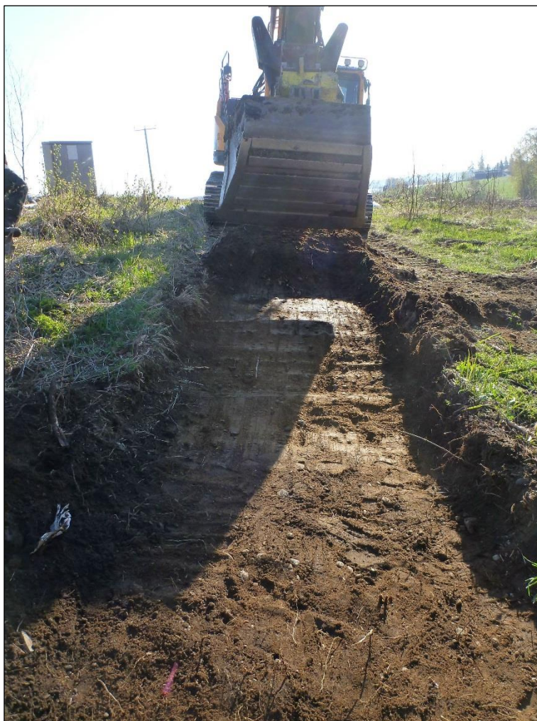
Tasoa peltomultakerroksen poistamisen jälkeen. Kuvattu itään.
