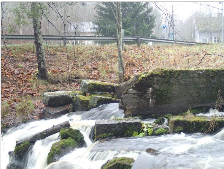
Kakkosenkulma. Lohkokivirakenteen jäännöksiä betonirakenteiden vieressä kosken partaalla. Länteen.
