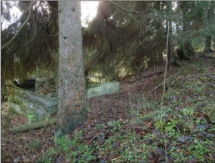
Hyväneula Linnamäki. Itäreunan alarinnettä, jossa betonirakenteen perustus. Etelään.
