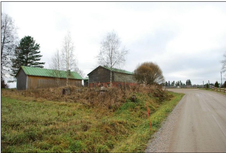
Porvola. Kylätontin itäisempi rakentamaton alue rakennusten etualalla. Länteen.
