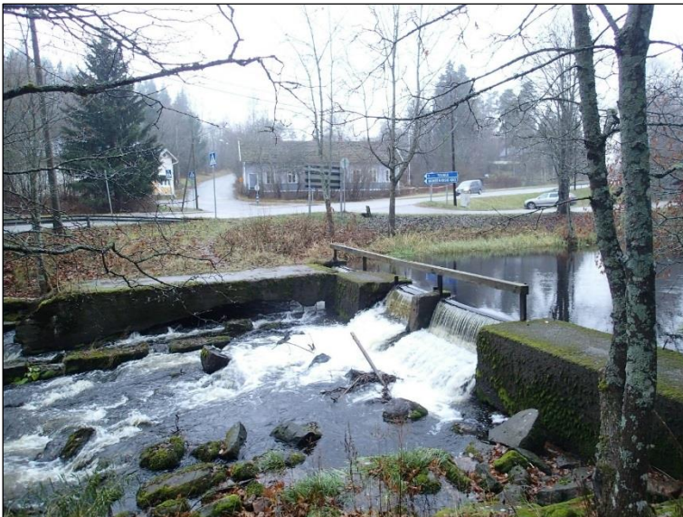
Kakkosenkulma. Betonirakenteiden jäännöksiä ja pato koskessa. Länteen.
