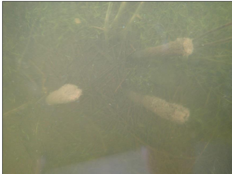
puurakenteita veden alla
