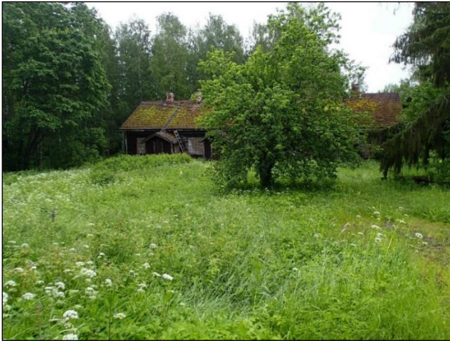
Rutolan Ropoisen talon entisellä tontilla oleva Gutzeitin 1900-luvun alun työväenasuinrakennus. Kuvattu itään.
