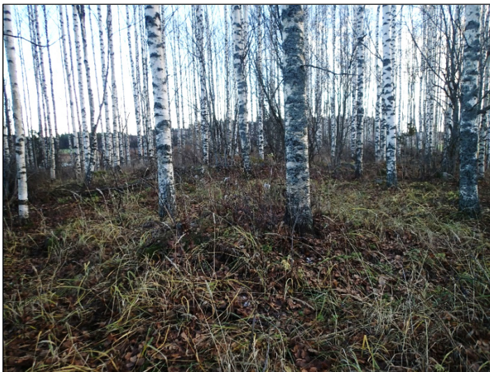
Kumpareen laen pohjoisosassa oleva rakennuksen perustus. Etualalla koi-vujen välissä oleva kumpare on tulisi-jän jäännös. Kuvattu kaakkoon.
