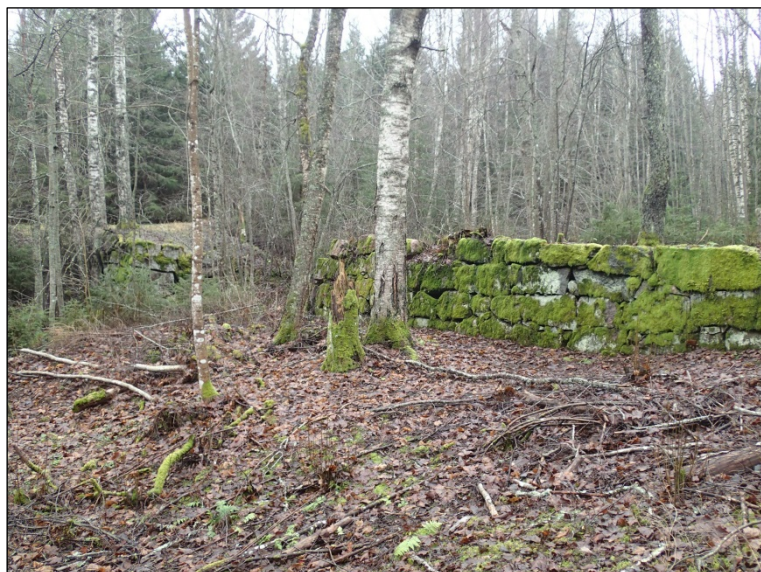
Joen pohjoispuolista patorakennelman kivimuuria.
