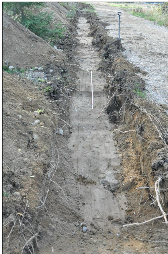
Pohjaan kaivettuna. Koillisesta.
