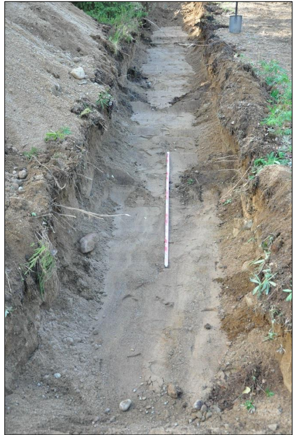
Pohjaan kaivettuna. Koillisesta.
