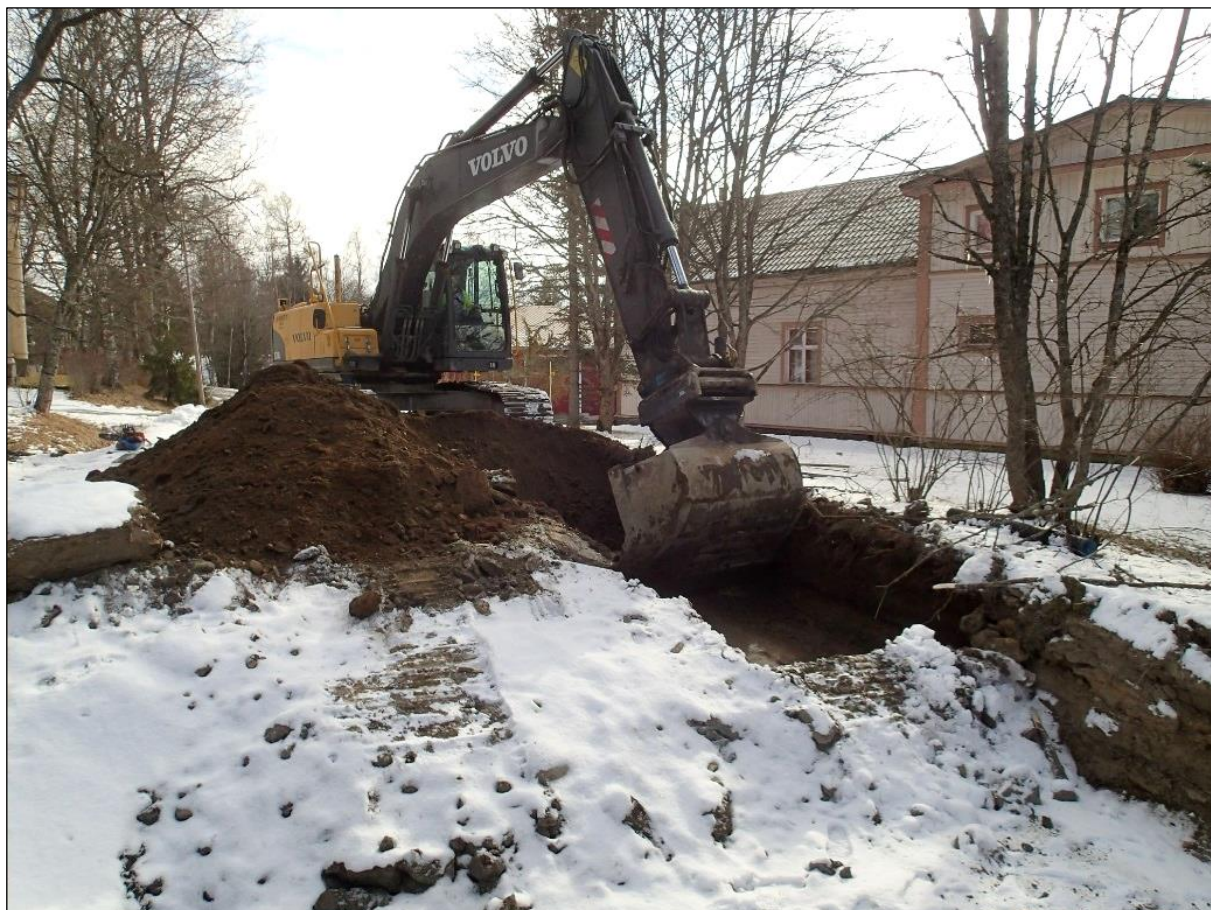
Koeojaa 1 kaivetaan. Kaakkoon.
