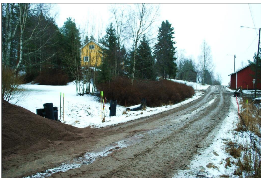
Tutkimusalueen luoteisosa ennen kaivutöiden aloittamista. Kaakkoon.
