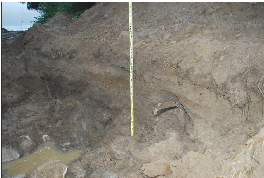
Kaivannon luoteiskulman sekoittunut kohta, paikalla betonin viemäriputki. Koilliseen.
