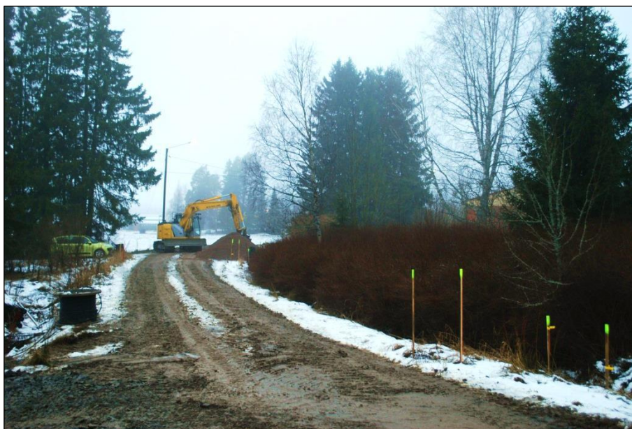
Tutkimusalueen kaakkoisosa ennen kaivutöiden aloittamista. Luoteeseen.
