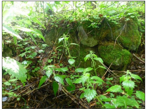
Kellarin kivistä tehtyä seinämää.
