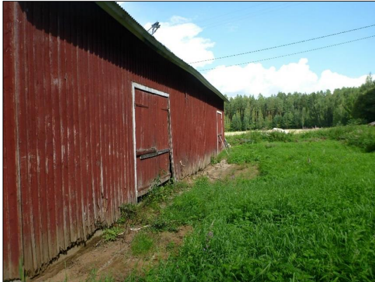
Konkintien ja Medelplanintien risteuksen kohdalla ladon edestä löytyi pintapöiminnassa rautakuonaa ja palanutta savea.
