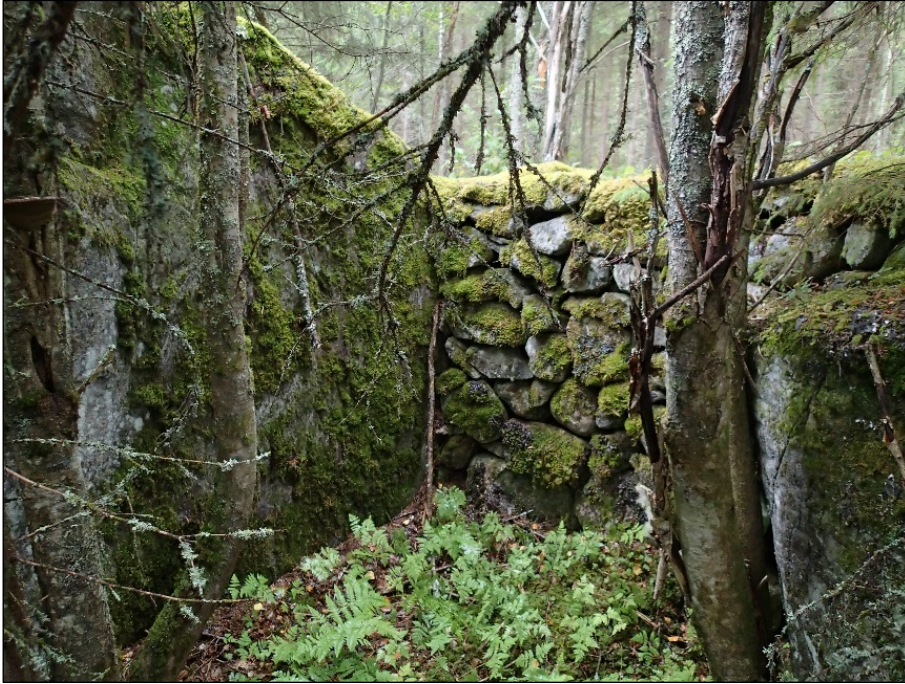
Kohdassa N 6880142 E 623473 sijaitsevan kivi- rakenteen (1) länsisei- nän kivijalkaa. Idästä.
