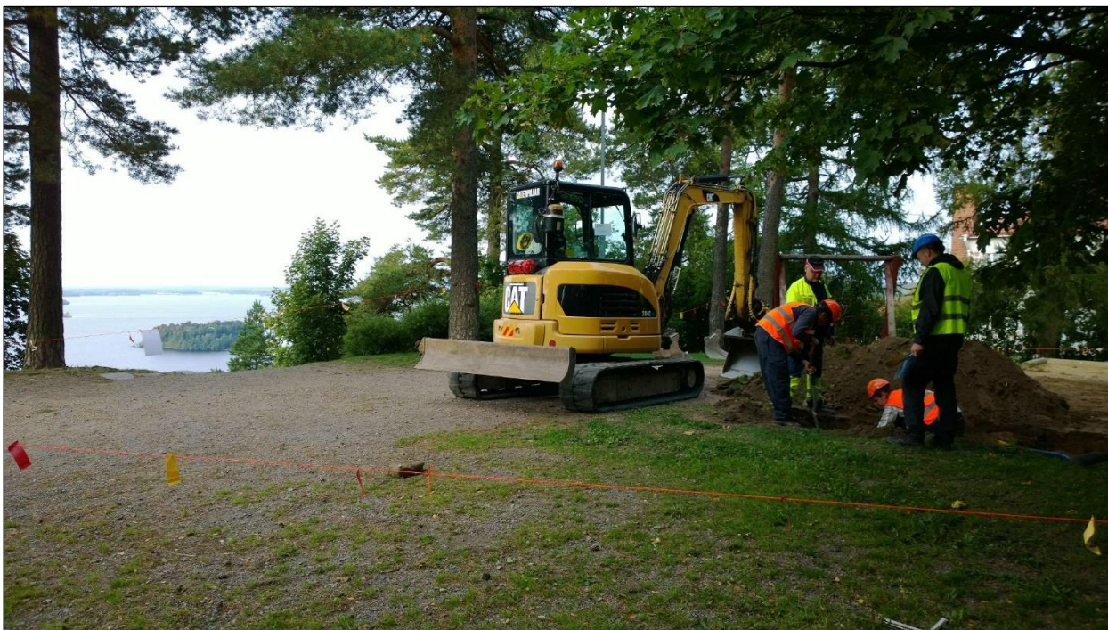
Koekuoppaa tarkastetaan kaivuun aikana.
