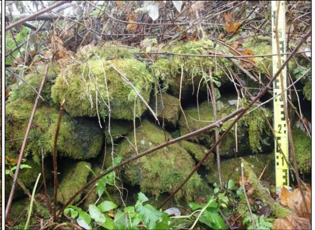
Kellarin jäännöksen kylmämuurattua seinää.
