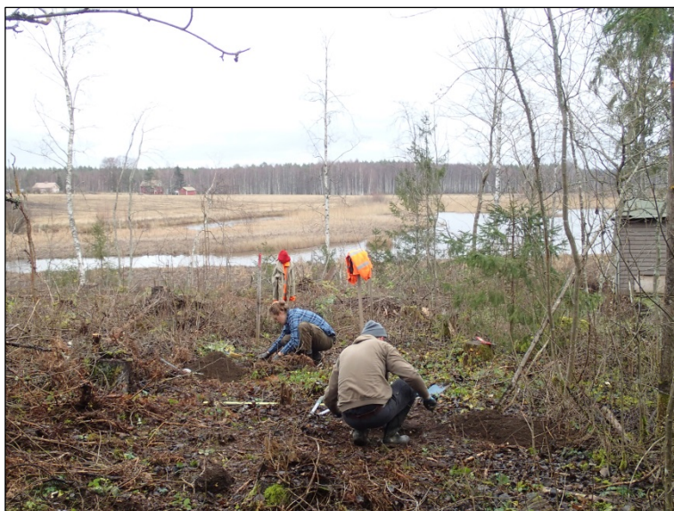
Köpinsaari. Koekuoppia kaivetaan. Pohjoisluoteeseen.
