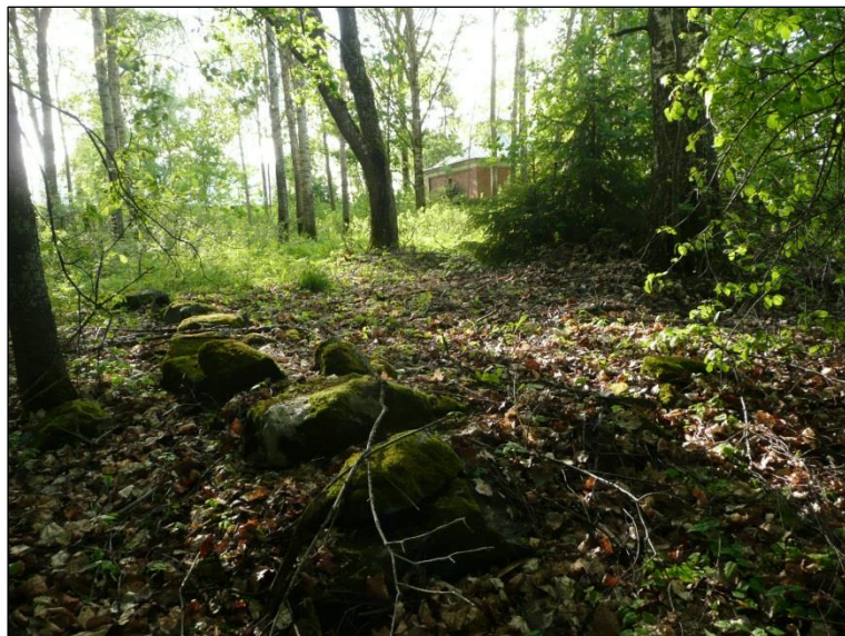
Rakennuksen perusta tontin itäreunalla
