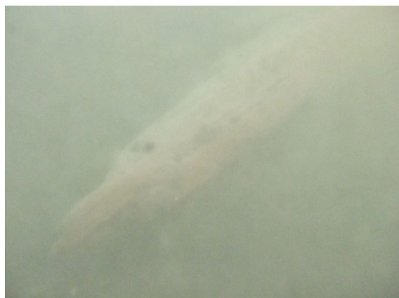
Kuva 13. Kuvassa erottuu vedenalaista puura- kennettä. Kuva Päivi Jantunen.
