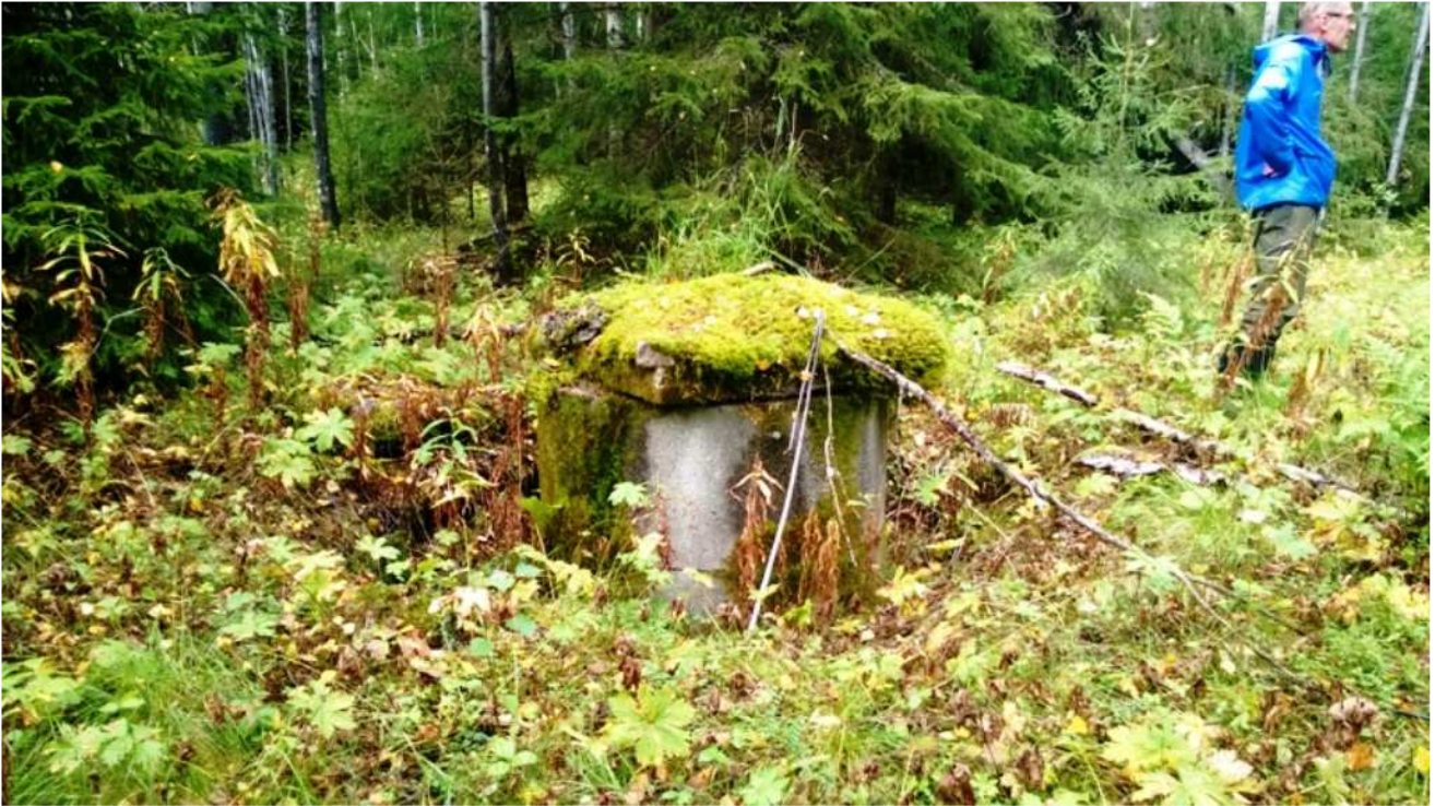
Kuva: Betonirengaskaivo alueen pohjoisosassa. Kuvassa Eero Kakkuri. Jouni Taivainen.
