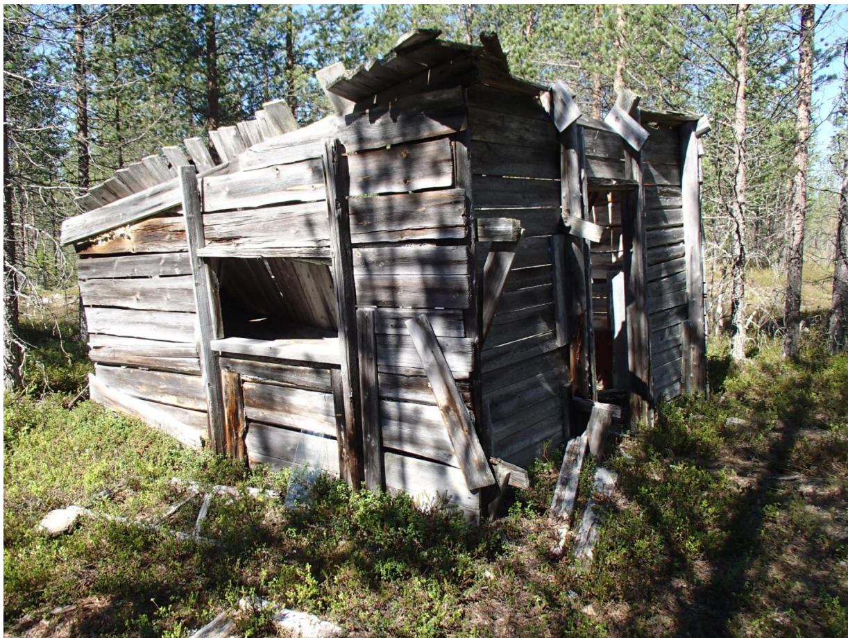
Yleiskuva rakennuksesta länteen.
