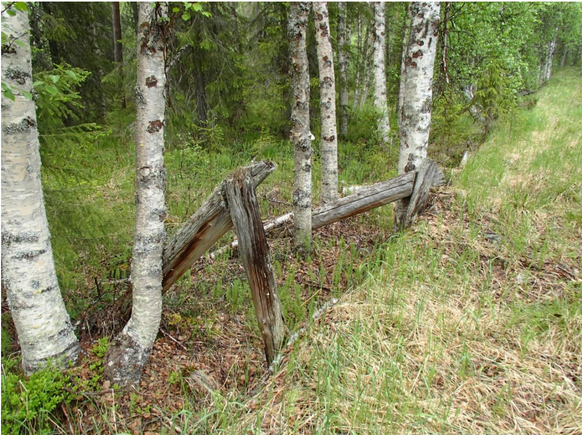
Tukirakenteita padon alavirran puolella lounaispäässä. Kuvattu pohjoiseen.
