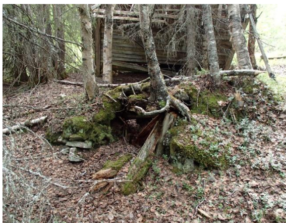
Maakellarin oviaukko ja käymälä kuvattuna etelään.
