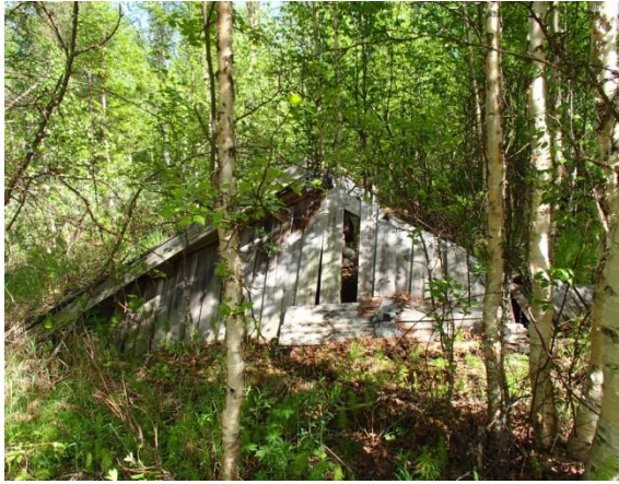
Saunan päätykolmio kuvattuna koilliseen.
