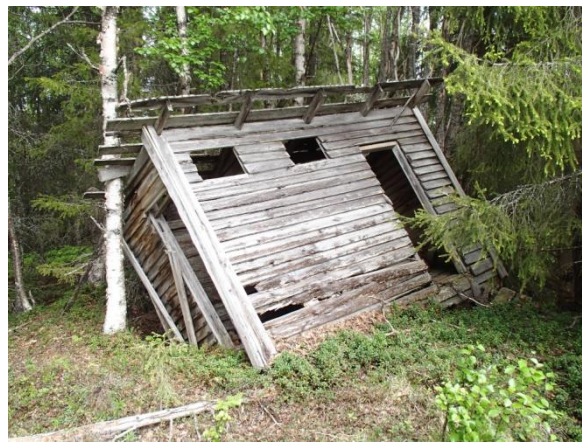
Käymälä on osittain kellarin kuopassa. Kuvaussuunta koilliseen.
