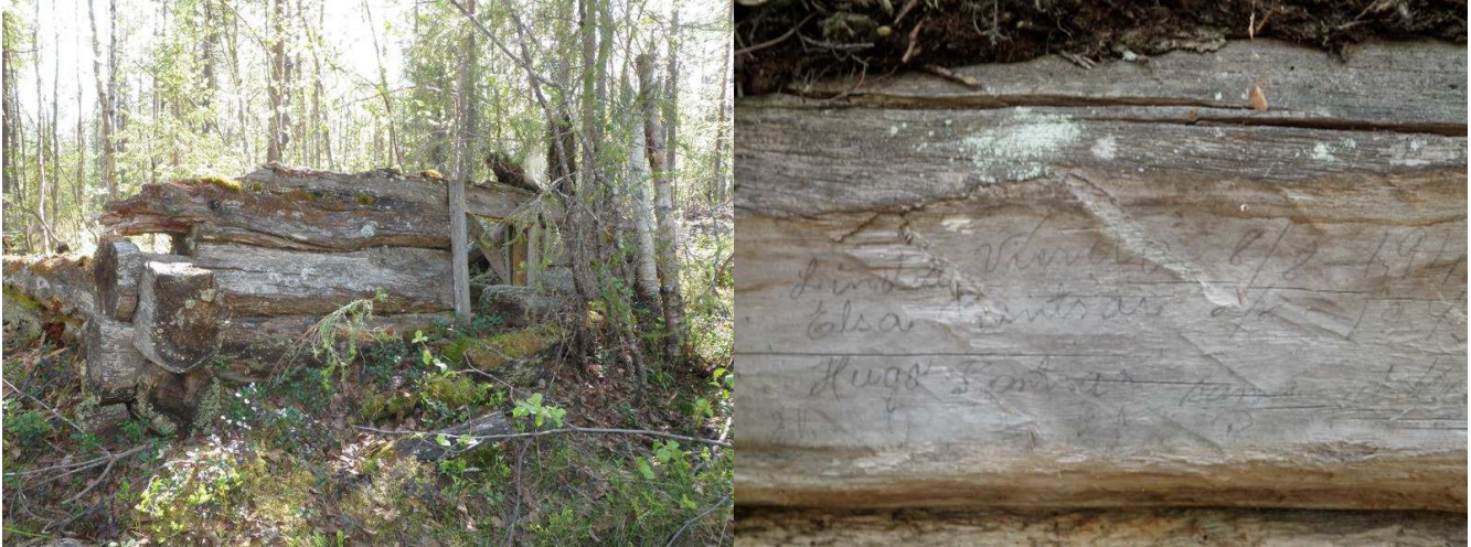
Rakennuksen pääty ja lyijykynällä tehtyjä nimikirjoituksia.
