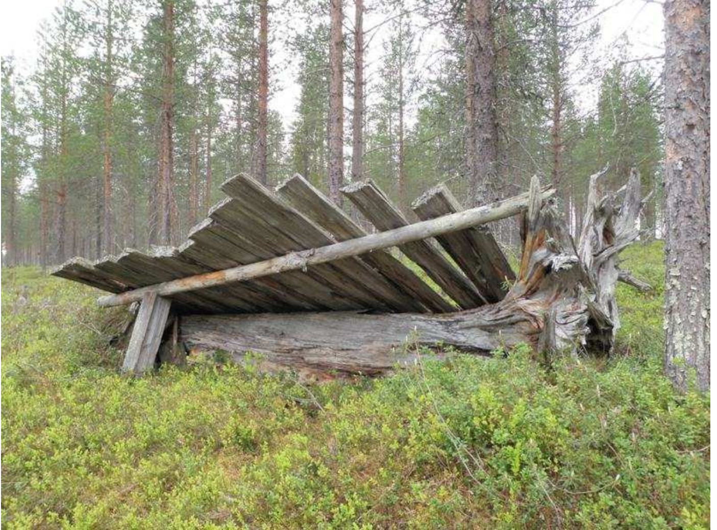
Laavu on rakennettu tuulenkaadon kannon varaan.
