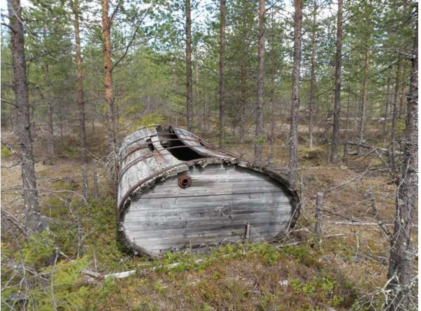
Vesipasa, jonka päällimmäiset laudat ovat lahonneet.
