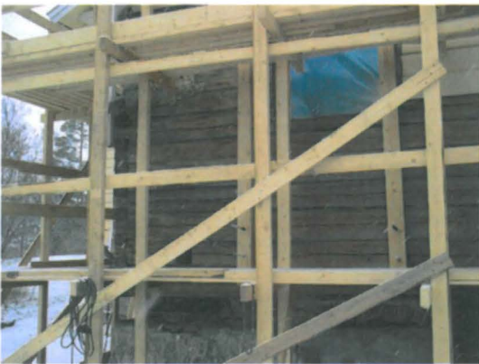
Olli Cavén MV/2008 Telineet työskentelyä varten. Ulkovuoraus on poistettu.
