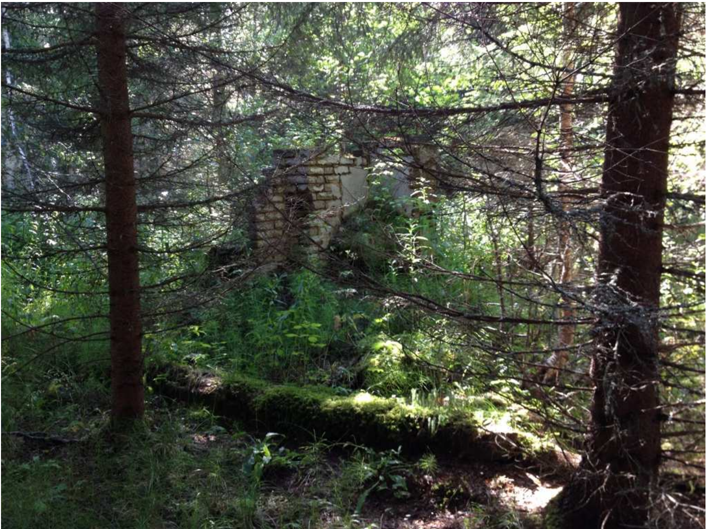
Kantola 2 päärakennuksen pohja. Kuvaussuunta etelä.
