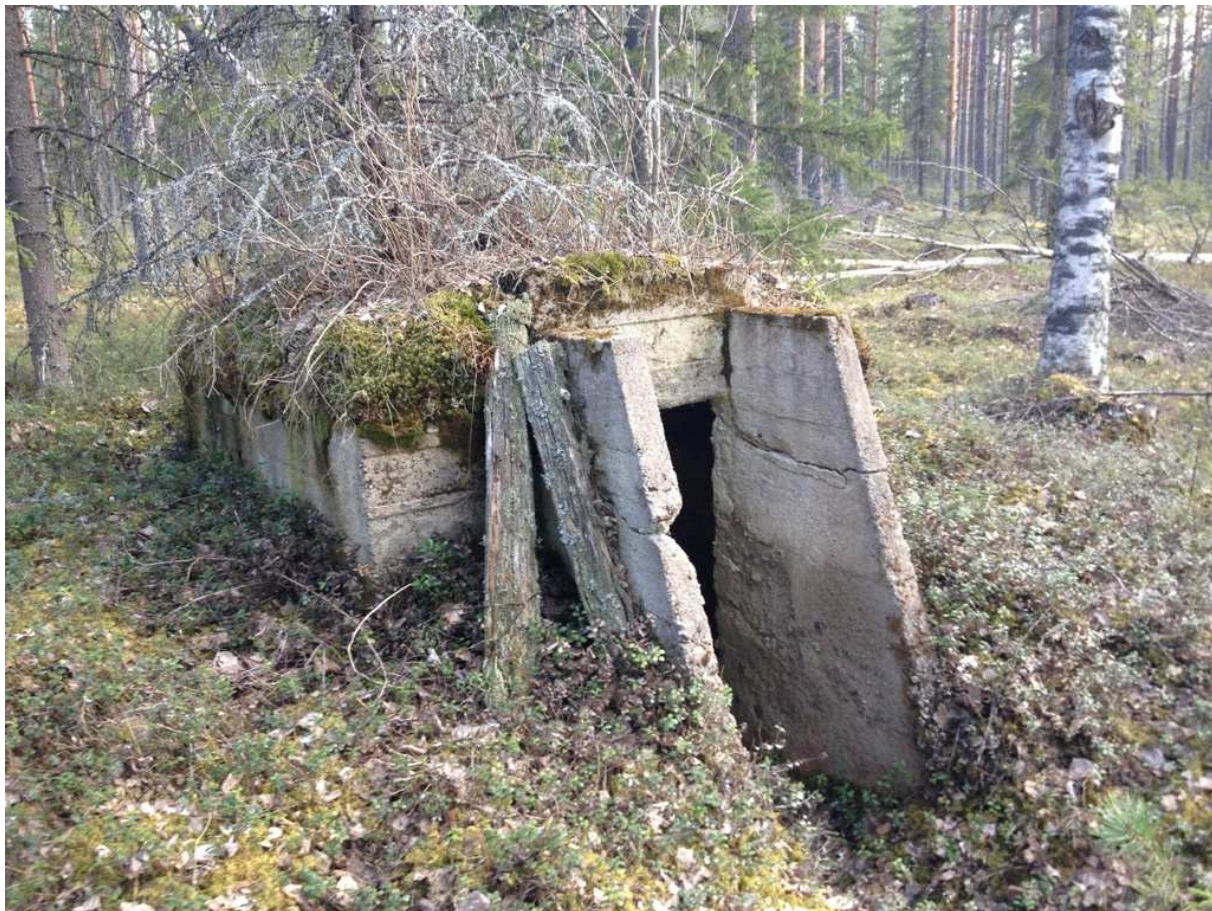
Kuva 4. Betonirakenteinen kellari Heinäsuon asuintilalta.
