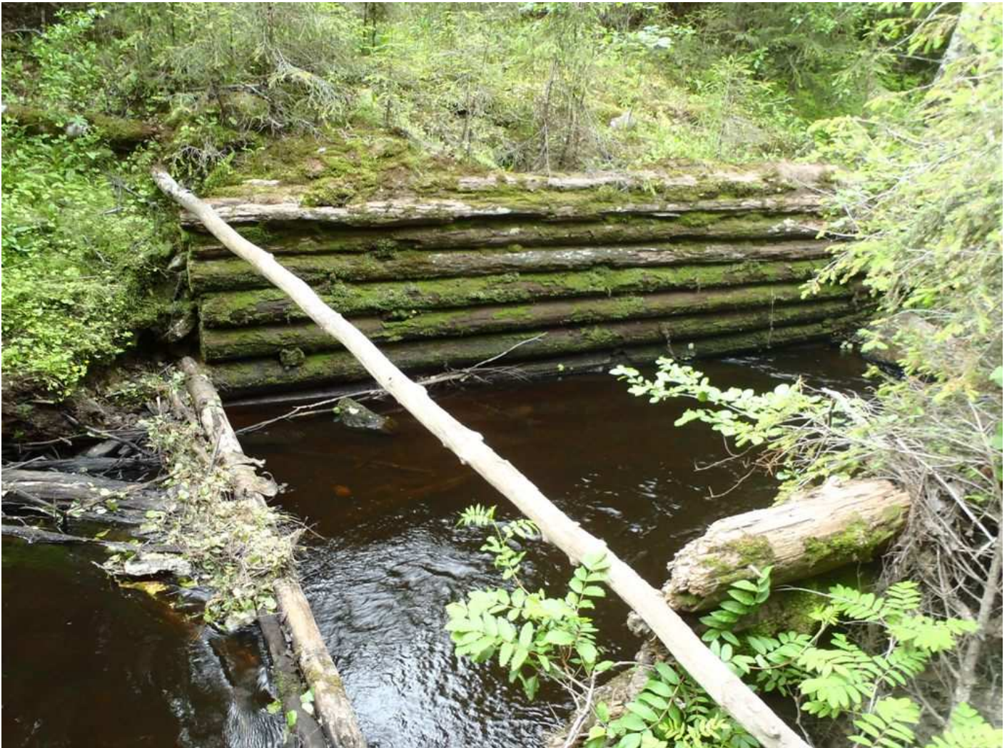
Utosjoki 9 silta jäännös. Kuvaussuunta etelä.
