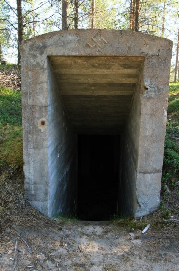
Kuva 170382_2. Yhä ehjänä olevan betonibunkkerin sisäänkäynti. Kuvattu luoteesta.
