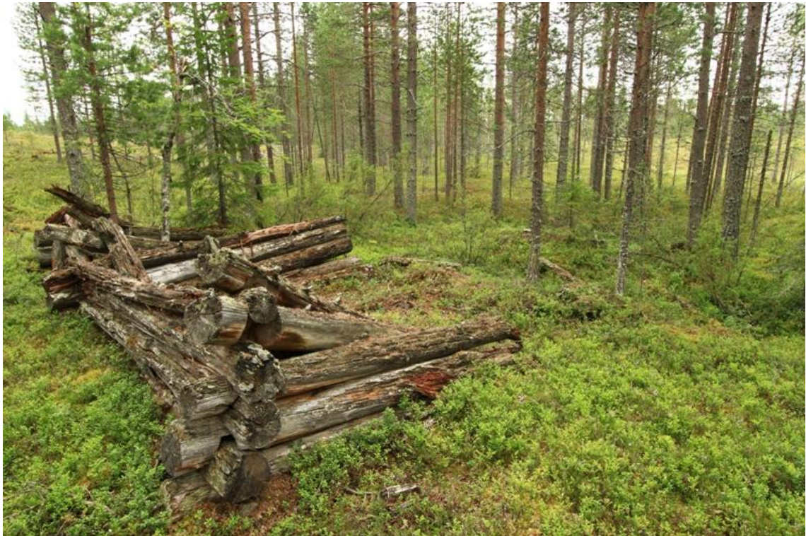
Kuva 170619_1. Yleiskuva kämpästä. Kuvattu luoteesta.
