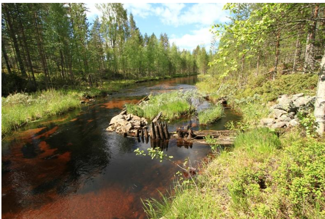
Kuva 170042_1. Uittotammi. Kuvan oikeassa laidassa näkyy kivistä tukirakennetta ja tammen puista ja kivistä rakennetta. Kuvattu idästä.
