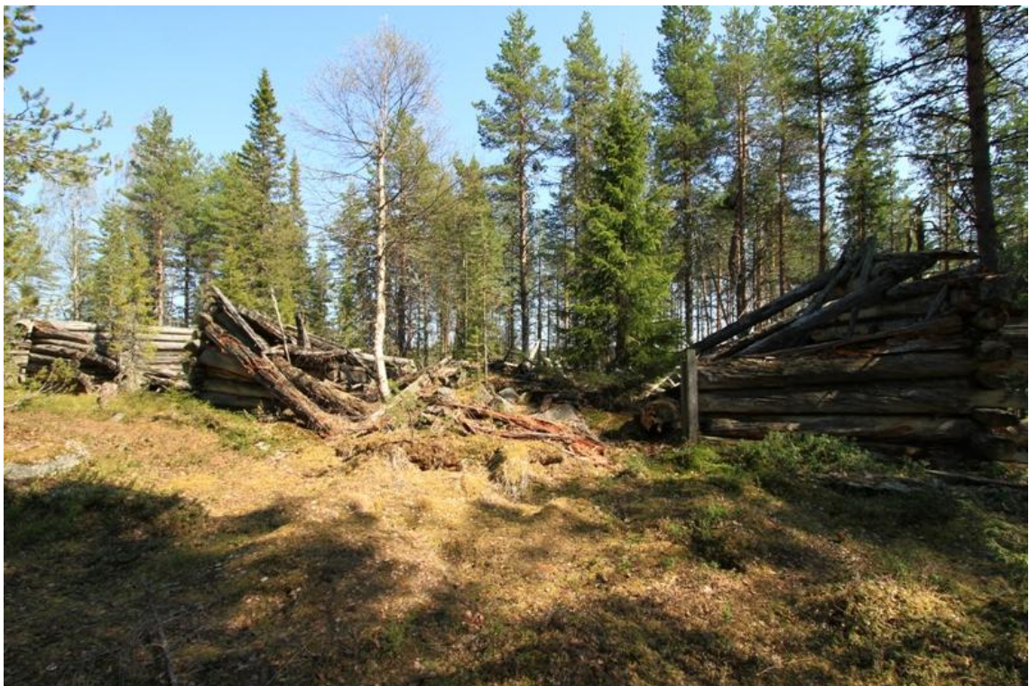
Kuva 169649_3. Rakennus 2, yleiskuva. Kuvattu lännestä.
