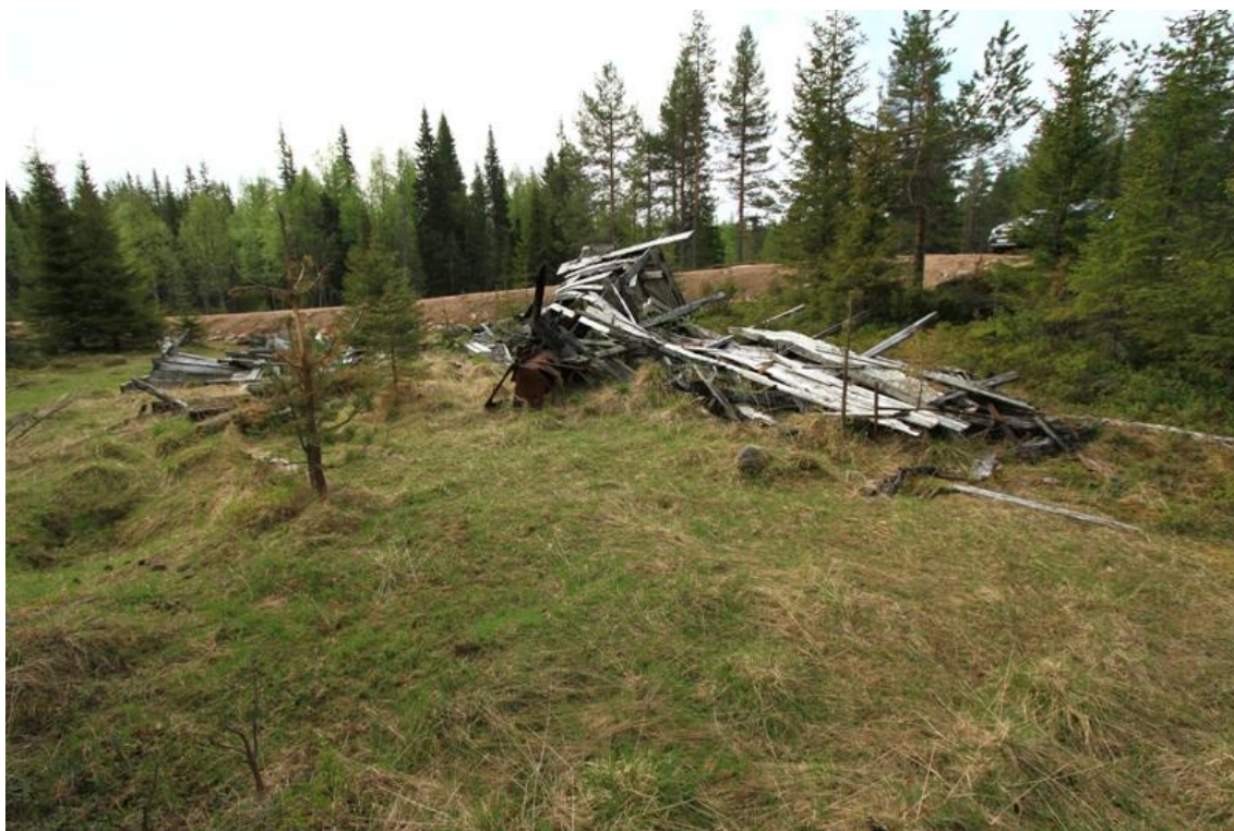
Kuva 169712_1. Yleiskuva rakennuksesta 1. Metsäautotie kulkee aivan sen vierestä. Kuvattu pohjoisesta
