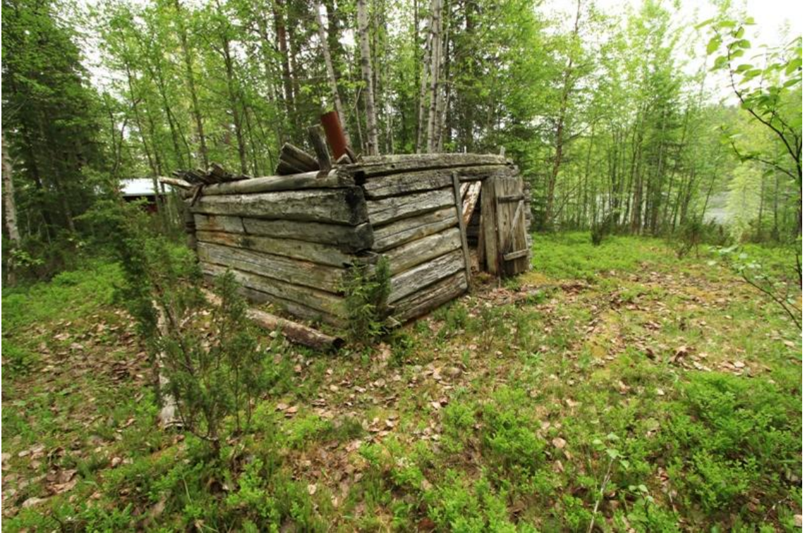
Kuva 169365_4. Rakennus 1. Kuvattu luoteesta.
