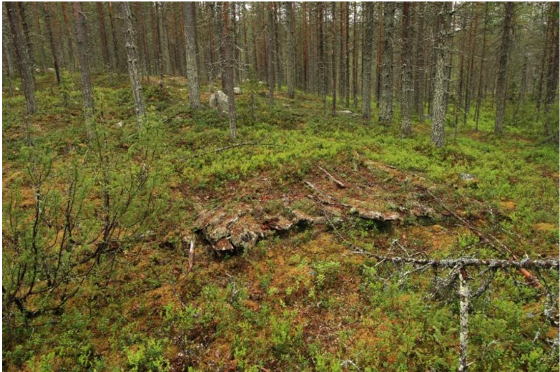
Kuva 169955_1. Laavu on jo romahtanut, mutta katerakenteet erottuvat maassa edelleen selvästi. Kuvattu lännestä.
