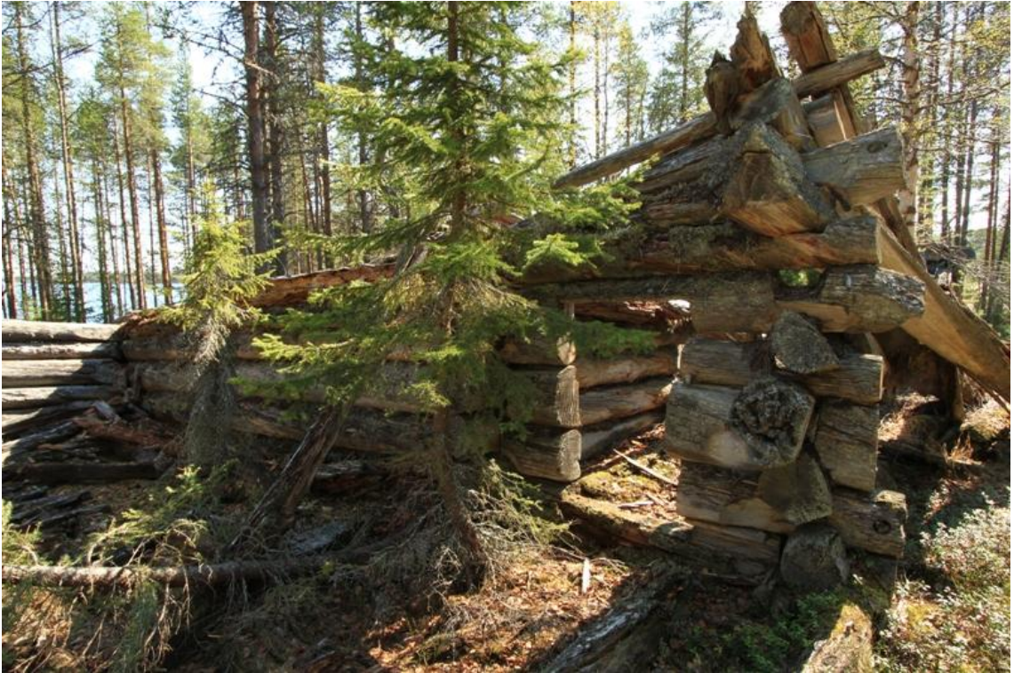
Kuva 169649_6. Rakennus 2, talliin tulevan porstua ovi. Kuvattu luoteesta.
