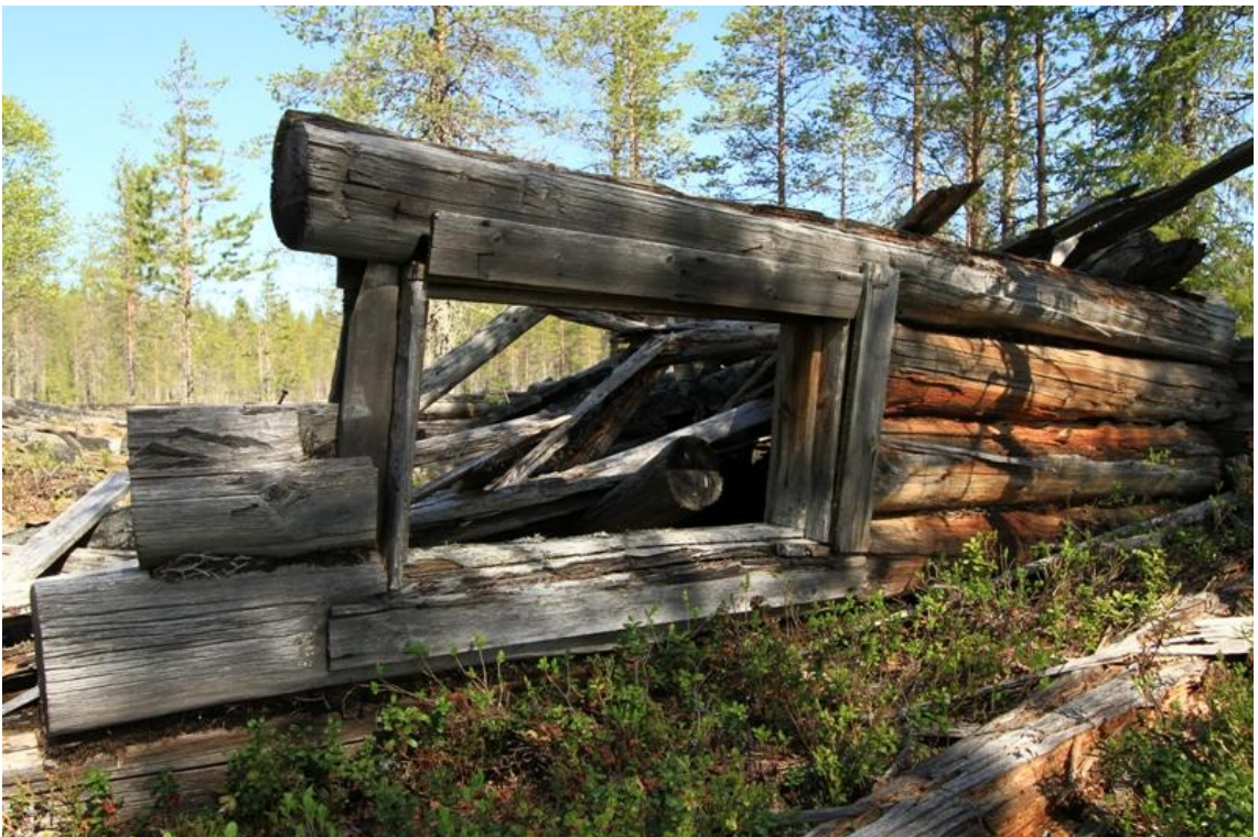
Kuva 169680_6. Rakennuksen 3, eli saunan, ikkunallinen seinä. Kuvattu etelästä.
