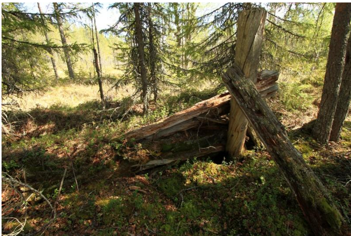
Kuva 169686_4. Pohjoisrannan patovallin puisia tukirakenteita. Kuvattu lännestä
