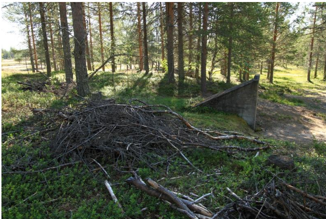
Kuva 170382_1. Yleiskuva kohteesta. Betoninen sisäänkäynti erottuu maastossa hyvin. Kuvattu luoteesta.
