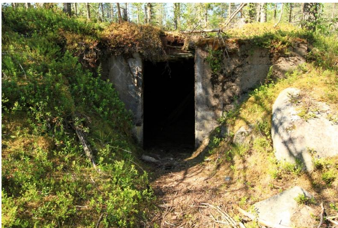
Kuva 170391_1. Betonikorsun oviaukko. Kuvattu idästä.
