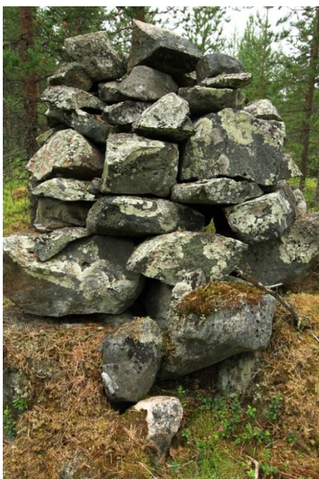
Kuva 170536_2. Kivilatomuksen rakennetta. Kuvattu pohjoisesta.
