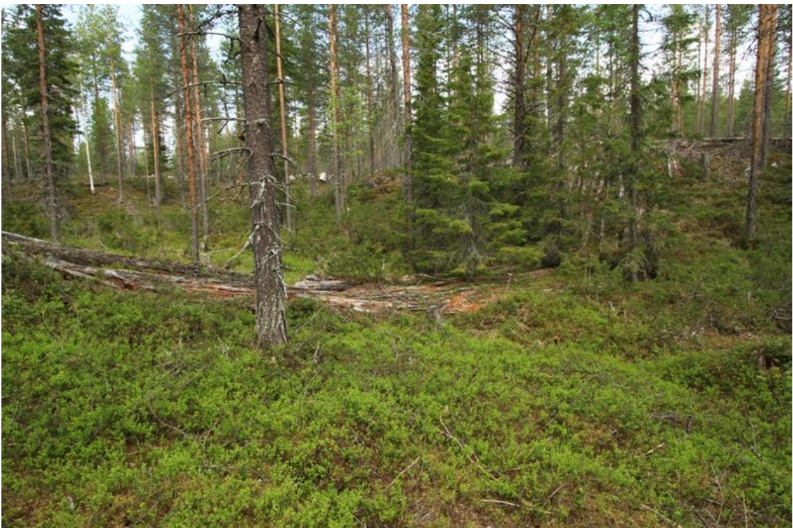
Kuva 169715_2. Pukkisillan puurakenteita kurun pohjalla. Kuvattu etelästä.
