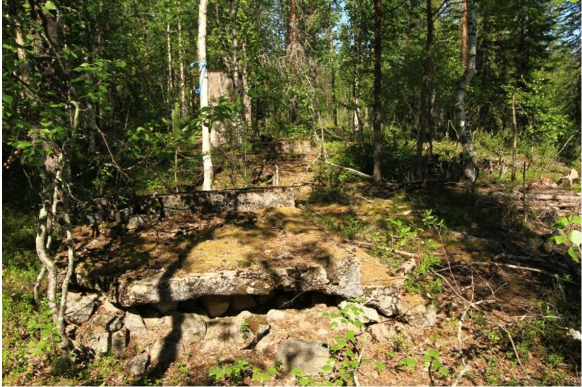
Kuva 170400_1. Rakennuksen 5 säilyneitä rakenteita. Kuvattu kaakosta.
