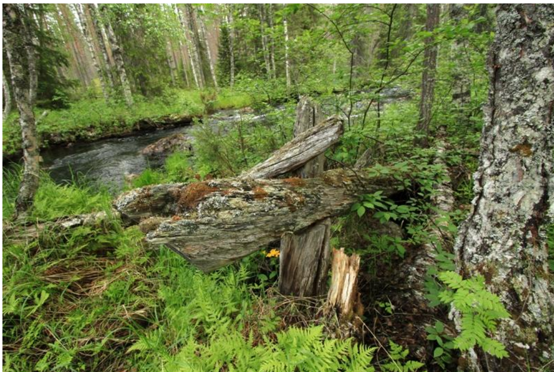
Kuva 170031_3. Pohjoisen patovallin eteläosan parhaiten säilynyttä puista tukirakennetta.
