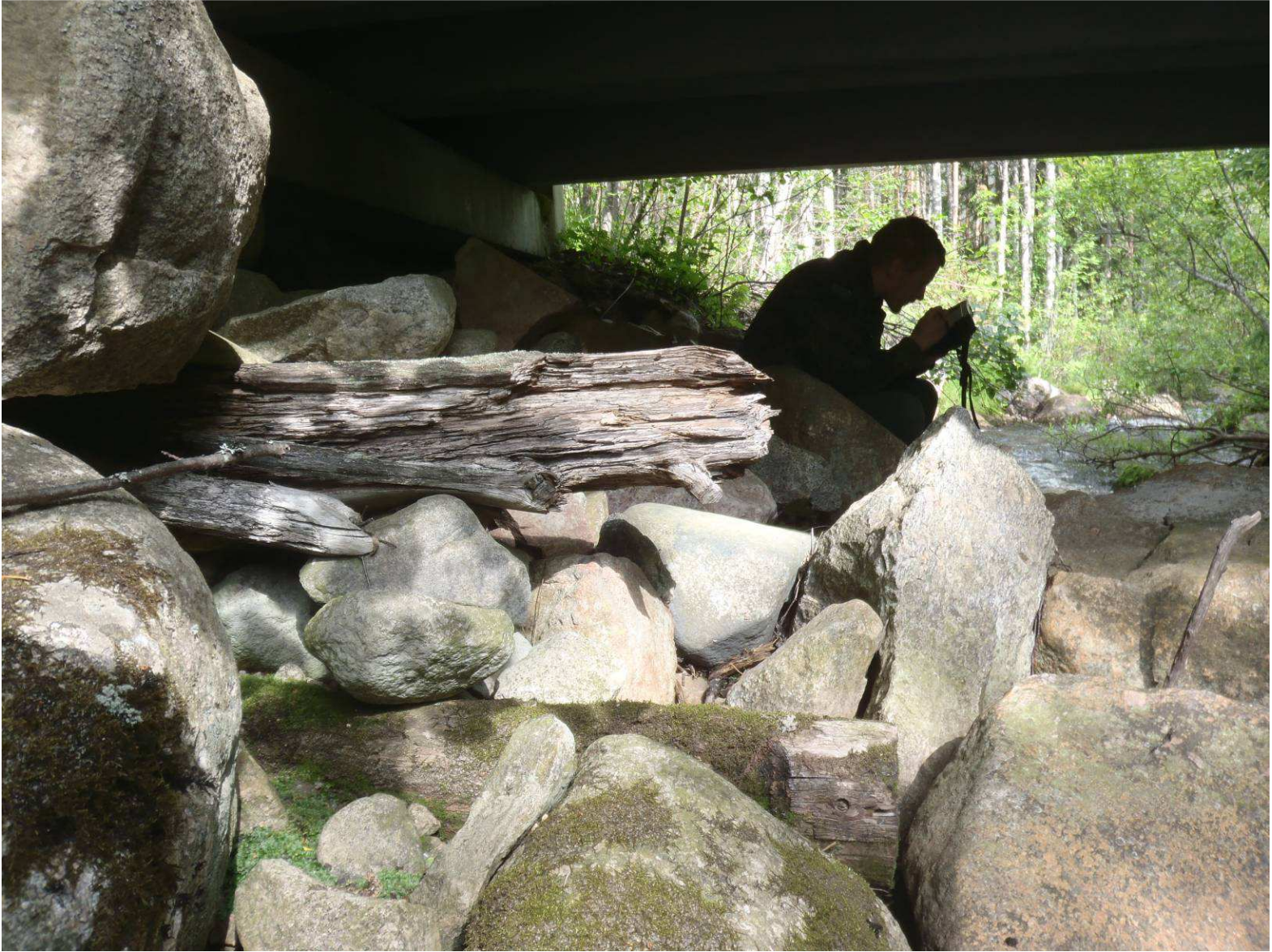
Kuva 171568 Tammissaari vanha silta. Etualalla vanhoja puurakenteita. Taustalla Olli Eranti kirjoittaa muistiinpanoja. Itään.
