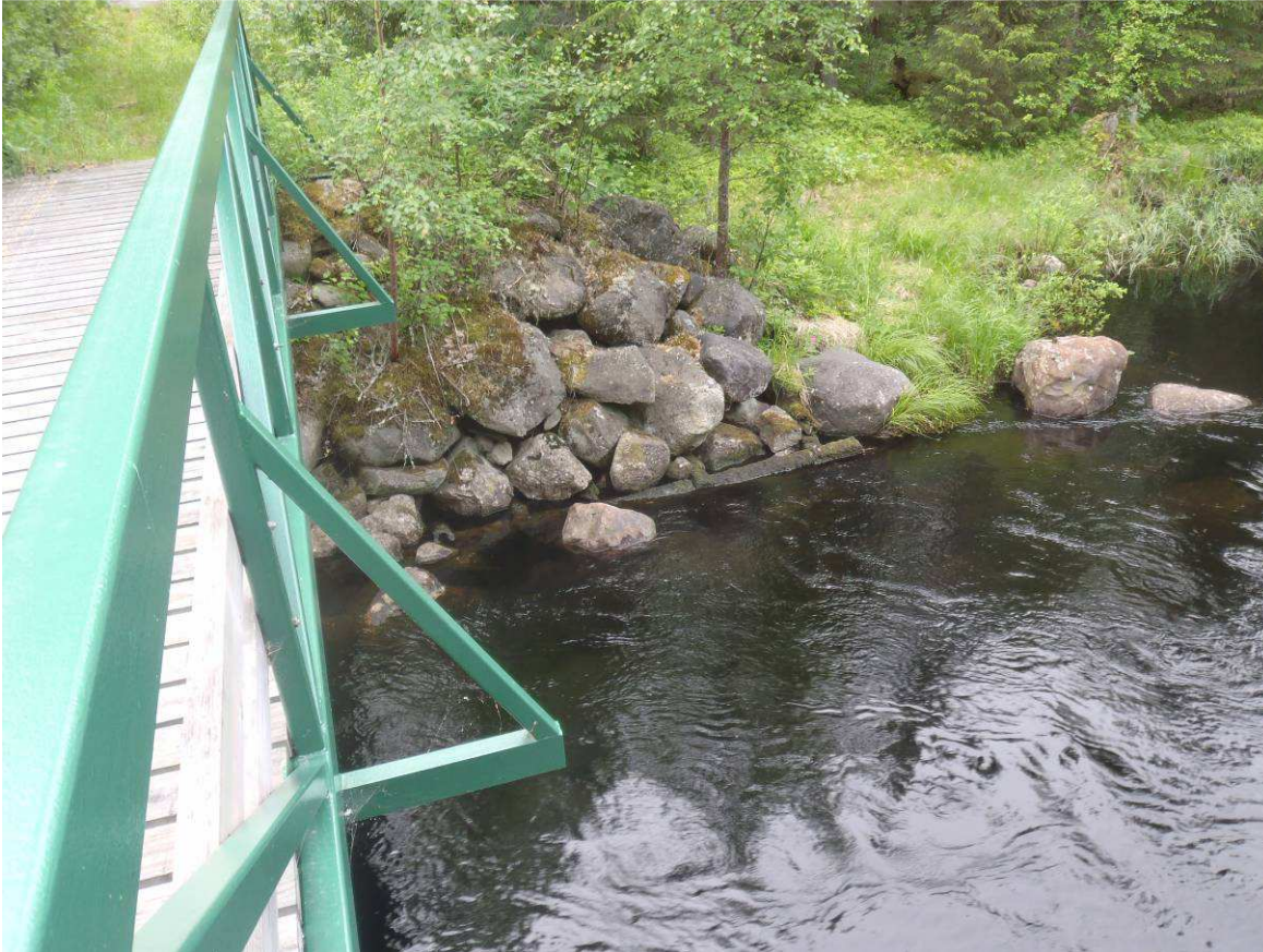
Kuva 171739_2 Rajakoski. Kivistä kasatun vallin alla on näkyvissä hirsiaarkkurakenteita. Pohjoiseen.
