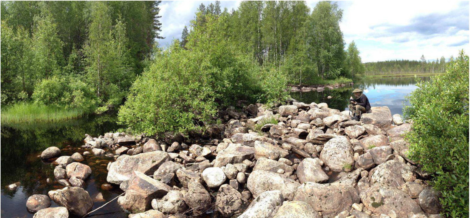
Kuva 171798_2. Rosvohodunsaari 2. Kivistä ja hirsistä rakennettu pato Haapajoessa. Pohjoiseen.
