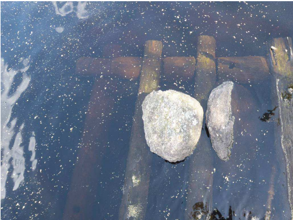
Kuva 172551_4 Paskopohja 2 vedenalainen rakennelma. Lähikuva puurakenteista.
