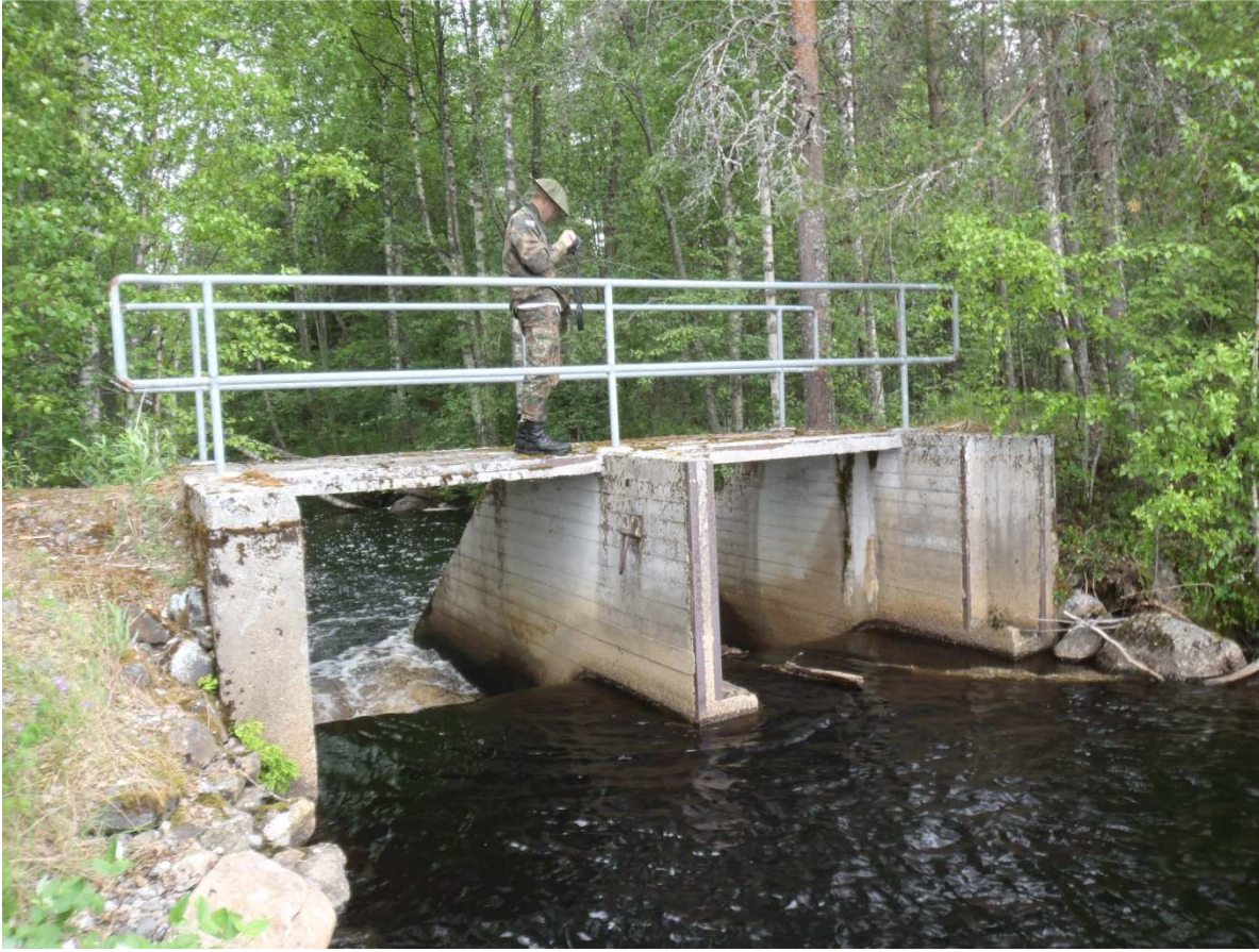
Kuva 172539_4 Hattukoski sulkupato. Luoteeseen.
