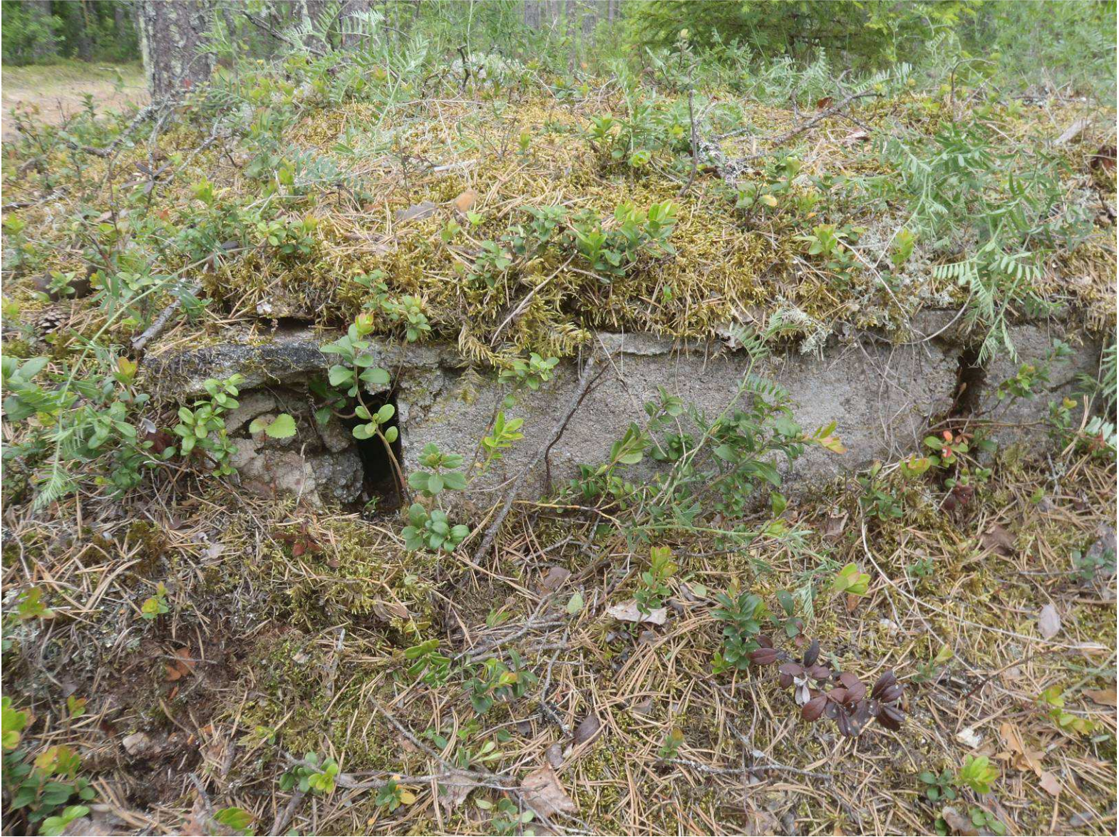
Kuva 171569_3 Kuorajoki 1. Yksityiskohta rakenteesta.
