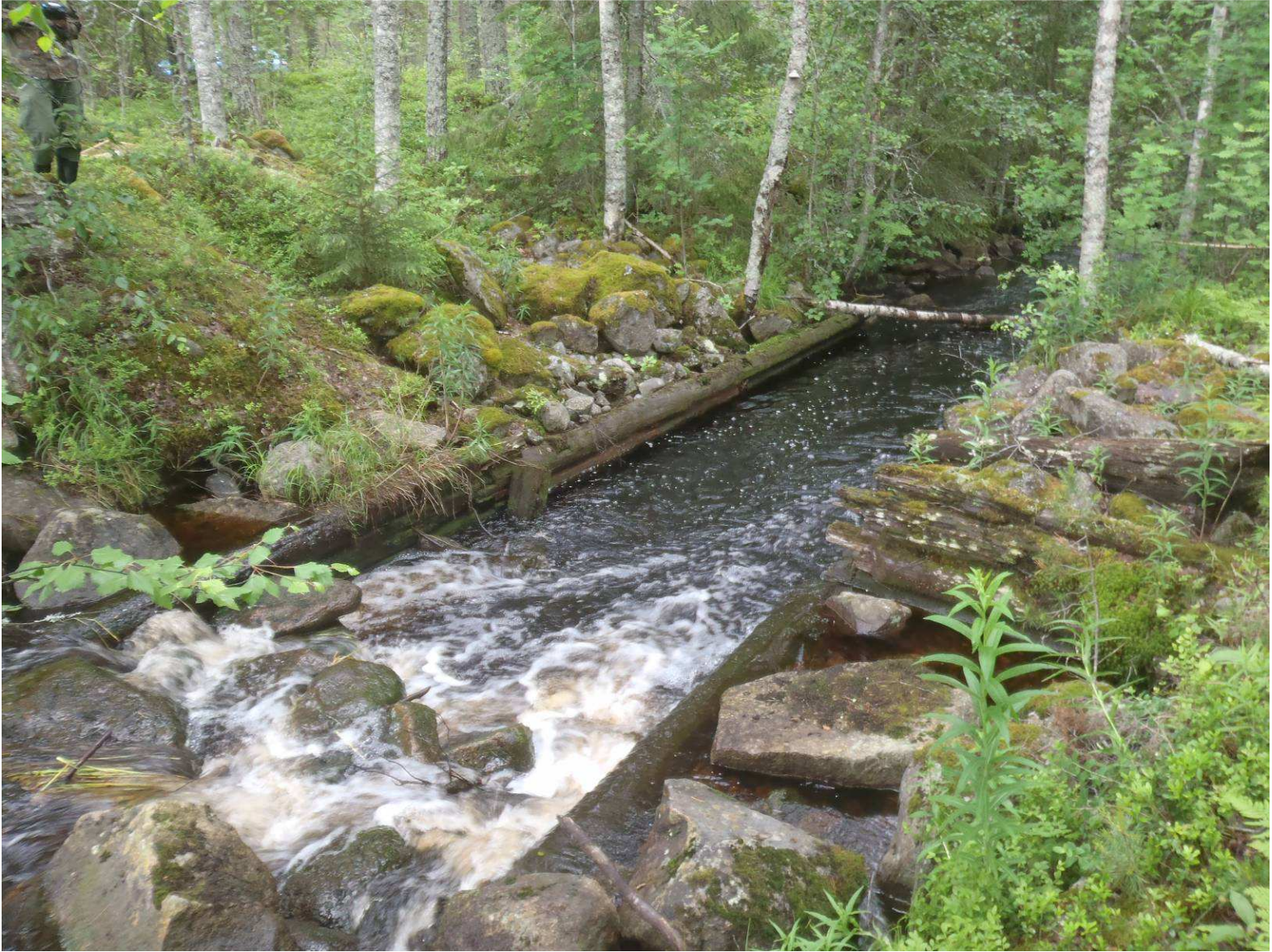
Kuva 171857. Hietapuro. Uittopadon jäännökset. Etelään.
