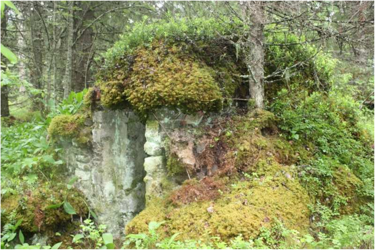
Kuva 59. Kellari, kuvattu pohjoisesta.
