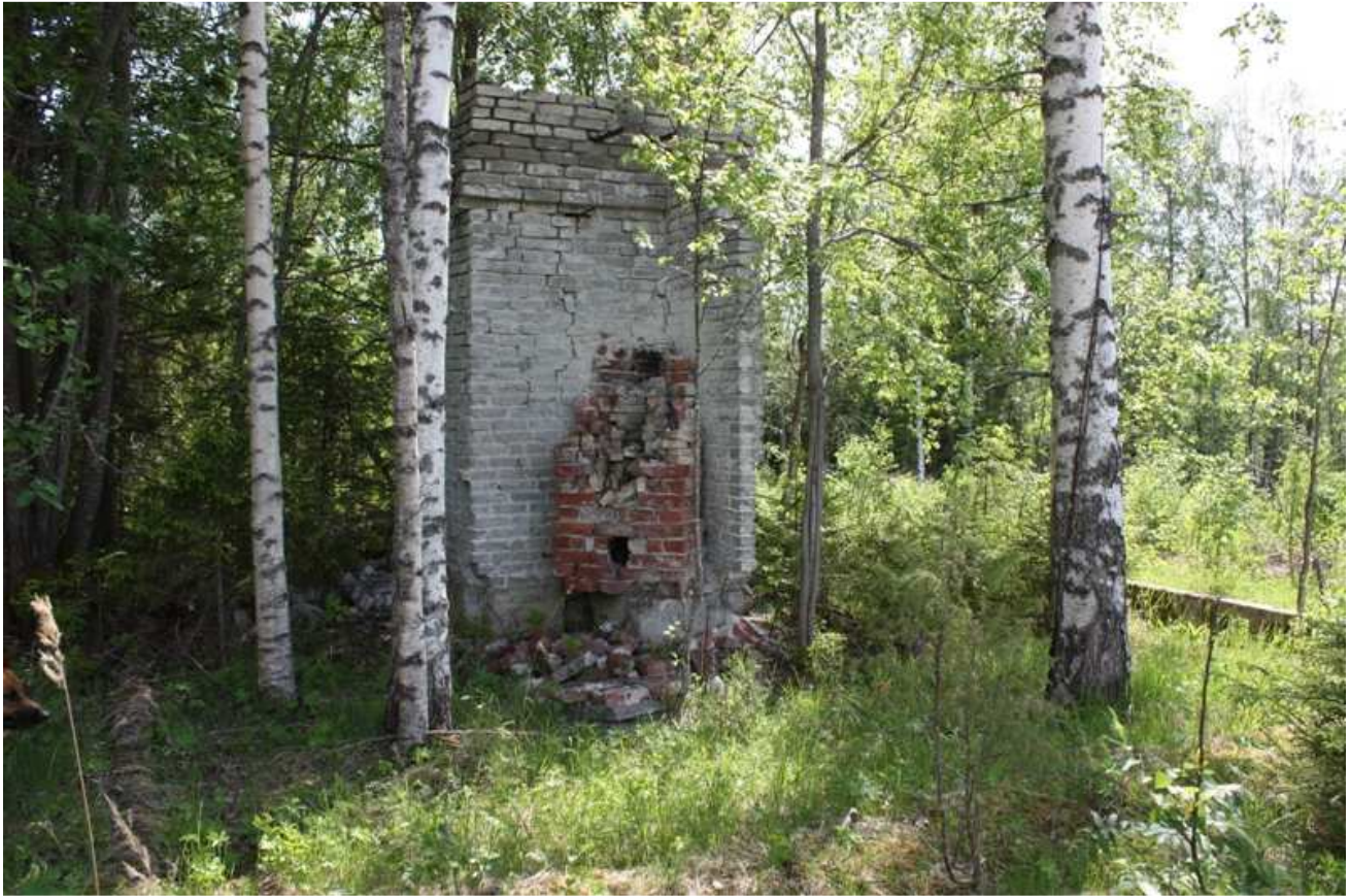
Kuva 50. Rakennuksen pohja ja tulisija, kuvattu luoteesta.
