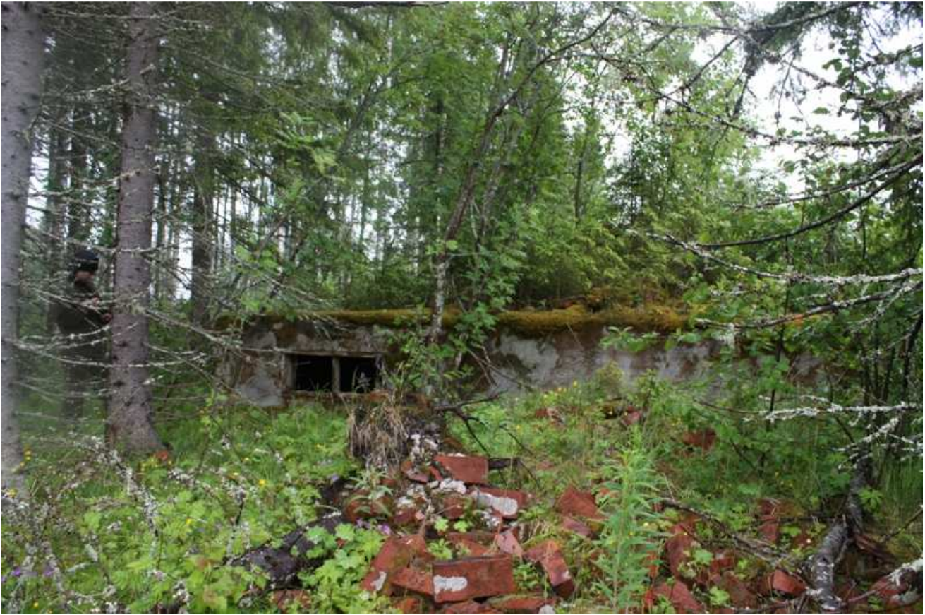
Kuva 61. Asuinrakennus, kuvattu luoteesta.
