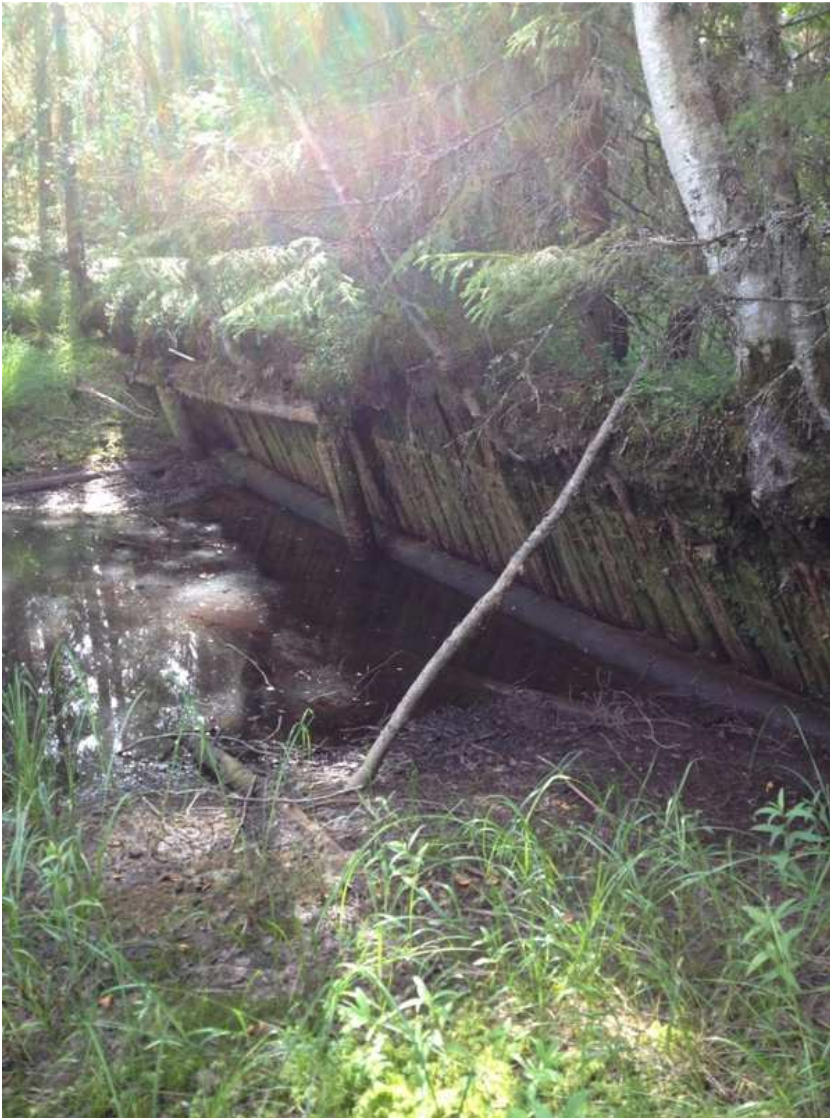
Kuva 130. Padon jäännös, kuvattu luoteesta.
