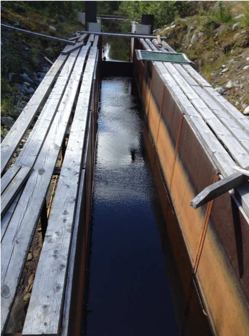
Kuva 120. Kanavan rakenteita, kuvattu koillisesta.
