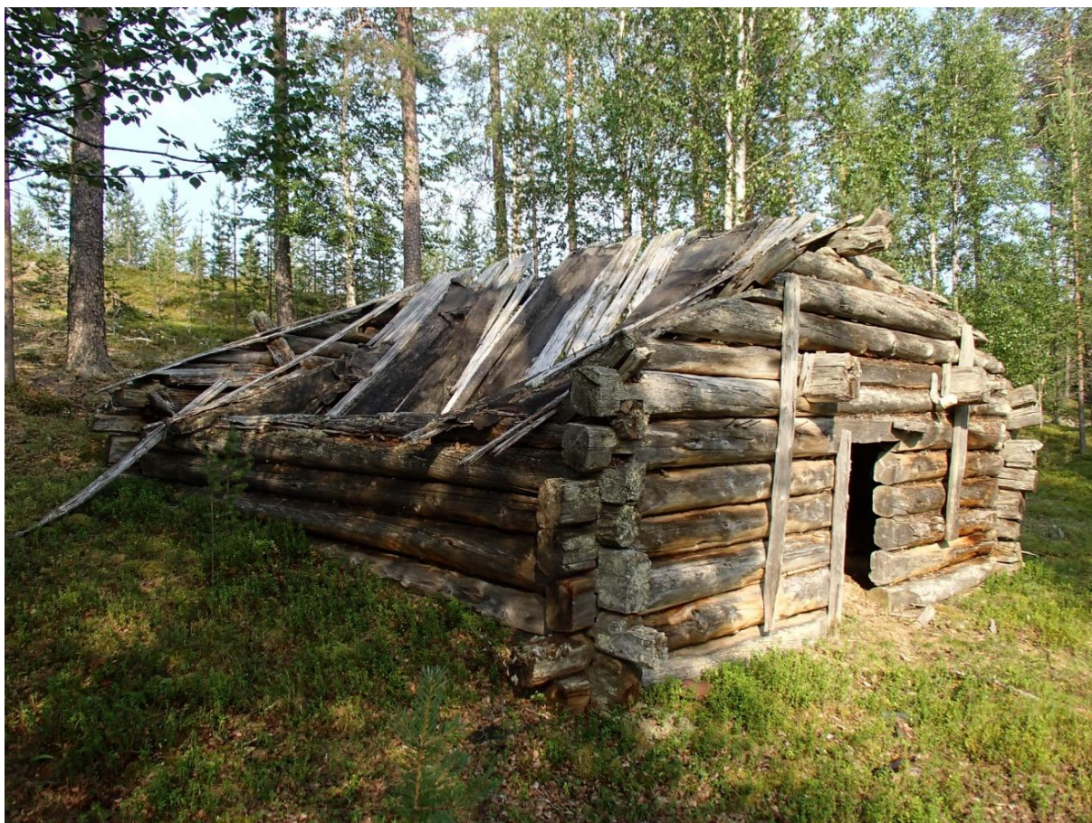
Kämppä on osittain kaivettu rinteeseen, kuvattu luoteeseen.
