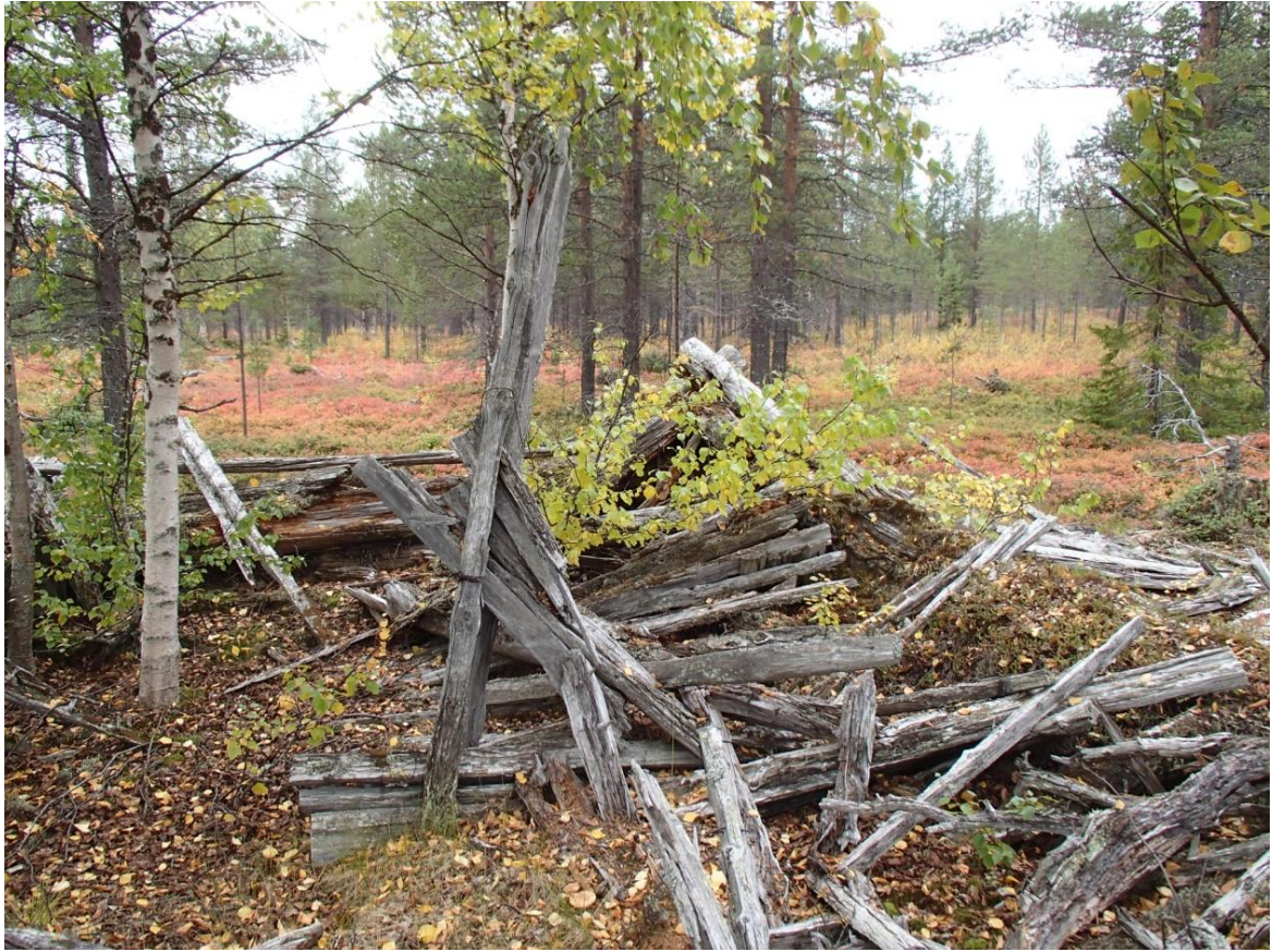
Pilttuiden rakenteita kuvattuna länteen.
