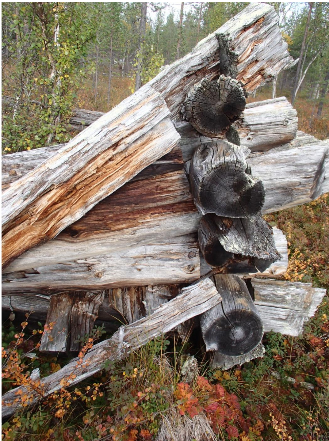
Kaakkoisnurkan salvos, lauteiden päät näkyvät hirsien välissä, kuvattu pohjoiseen.
