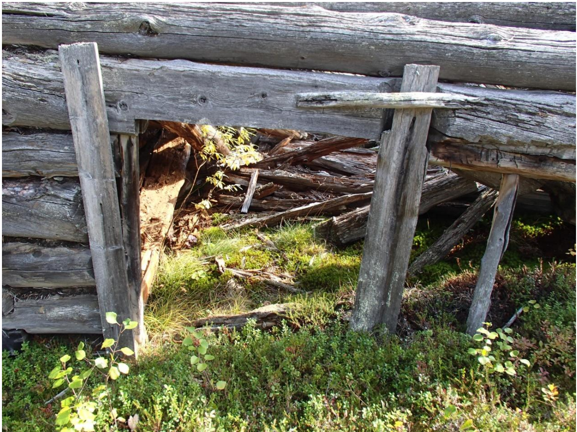
Länsipäädyn oviaukko kuvattuna itään. Ovenssa on ollut puusaranat. Oven eteläpuoleisen seinän alimmat hirret ovat maatunteet.
