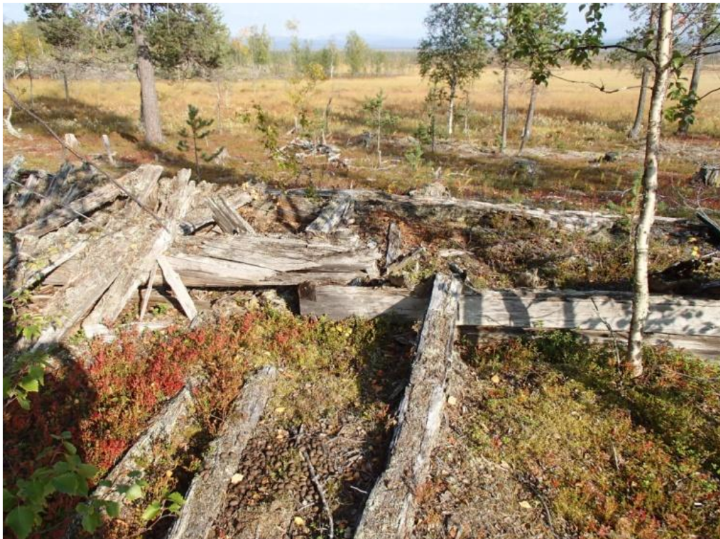
Kämpän 2 laverin kehikko ja kattopuita kuvattuna pohjoiseen.
