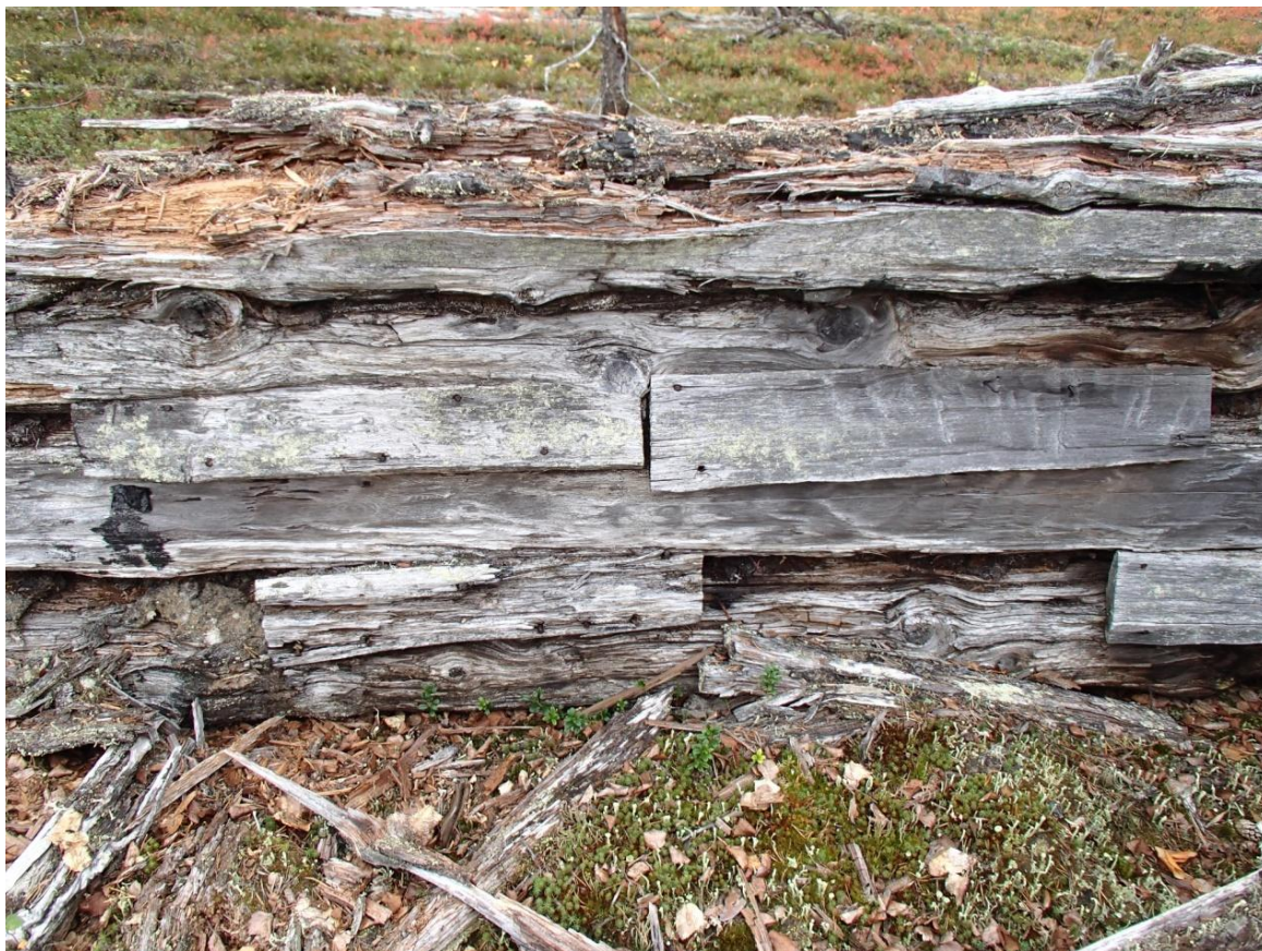
Eteläseinällä on hirsien rakoja peitetty laudoilla, kuvattu etelään.
