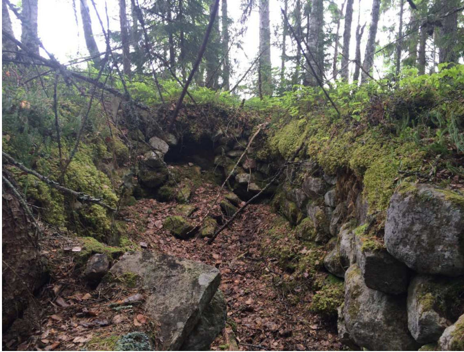
Kuva 20. Halmelahden kruununmetsätorpan pihapiiristä löytyi suuri kylmämuuraamalla tehty uunin jäännös. Torppaan liittyy tarina epäonnisesta karhunmetsästyksestä, jossa metsästäjät joutuvat juoksemaan karhua pakoon uuniin.
