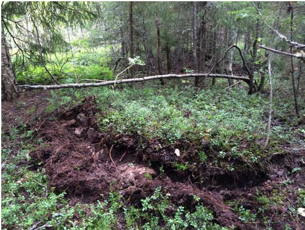
Esiin kaivettua parakin perustusta.
