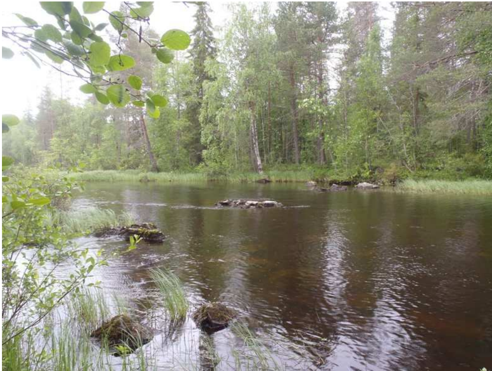
Sillan kivisiä perustuksia joessa.
