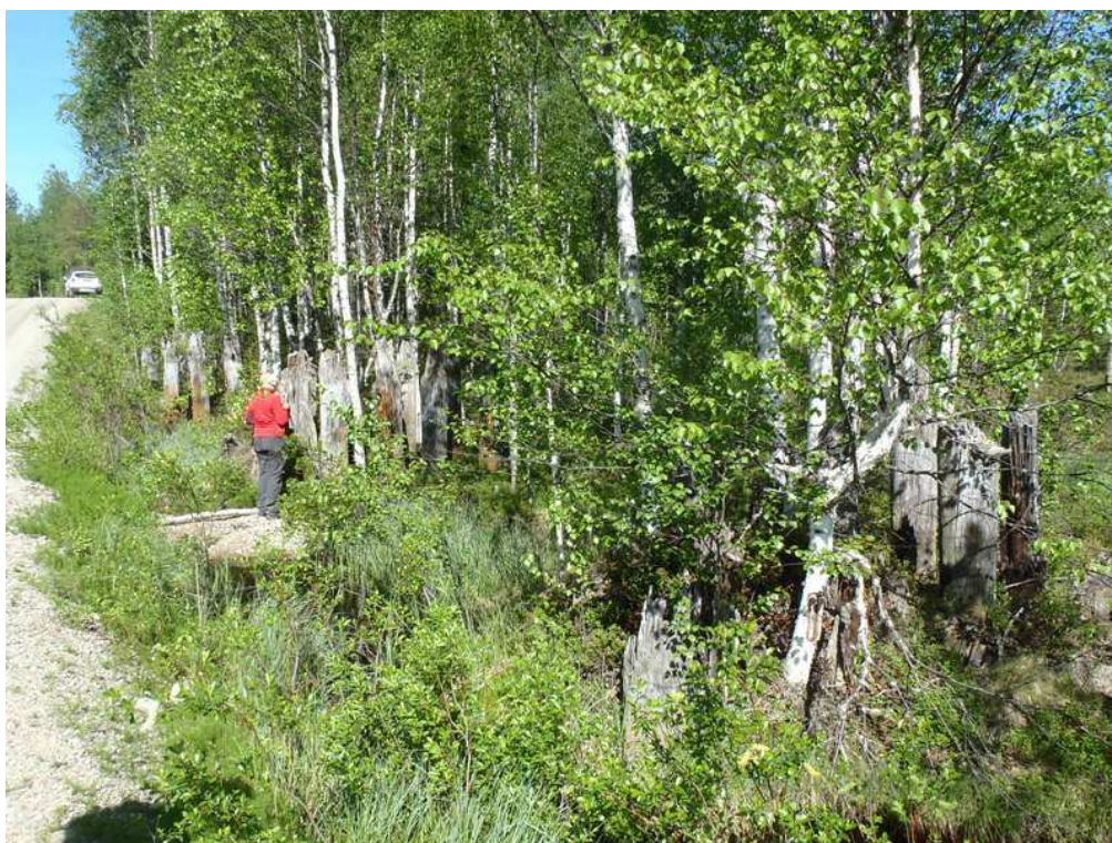
Hanna Kelola-Mäkeläinen dokumentoi sillan rakenteita.
