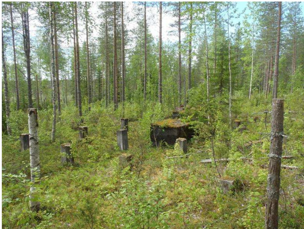
Myöhemmin rakennettujen rakennusten betonisia perustuksia.
