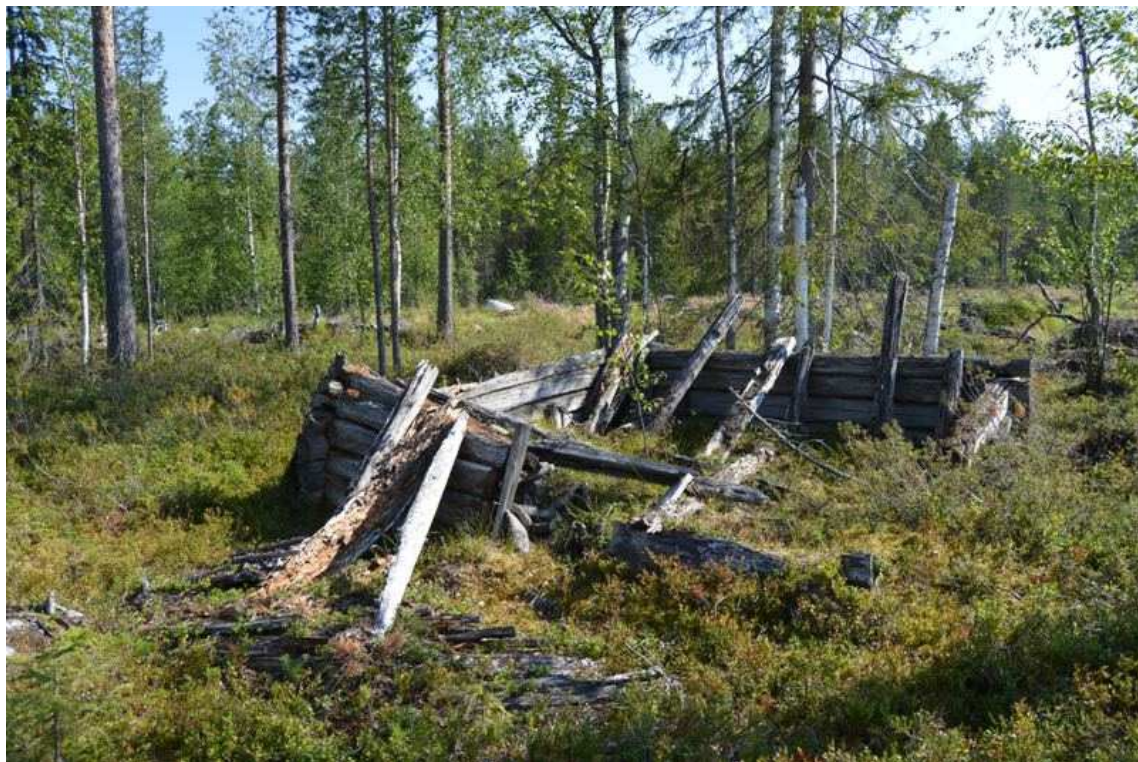
Yleiskuva rakennuksen jäännöksestä.
