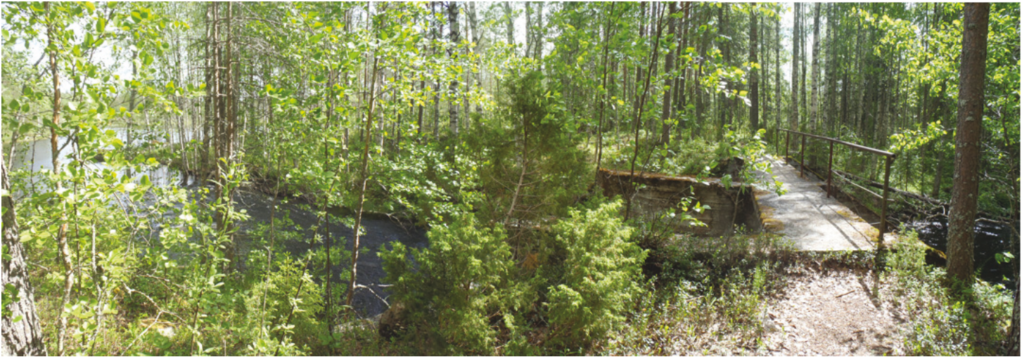
139142.116-118: Betoninen uittopato Kivijärven eteläpäässä, Kivijoen suulla. Panoraamakuva.
