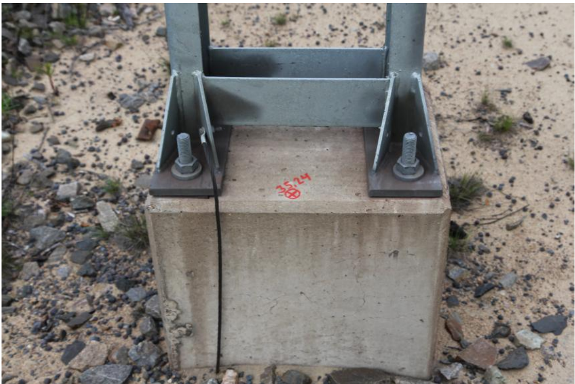
Kuva 4. Korkeuskiintopiste (35,24 m/mpy) johdinpylvään anturassa (MH-12_digi_28). Kuva: Janne Ikäheimo.
