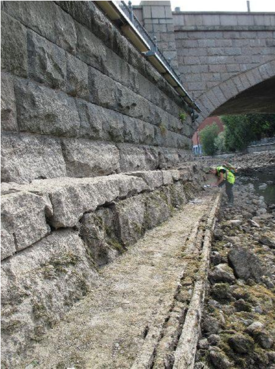
Hämeensillan itäpäähän ja rantapenkan kulman puiset ja kiviset tukirakenteet pohjoisesta kohde 10 b. Hannele Kuitunen
