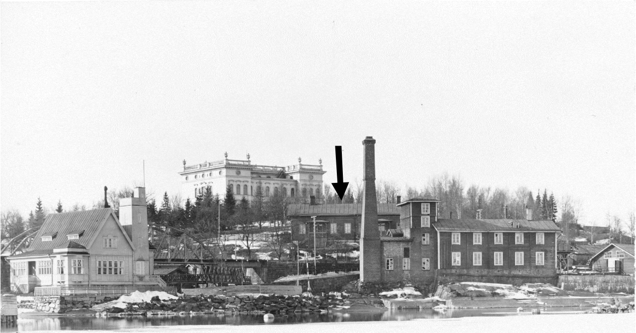
Mältinrannalla sijainnut Tampereen hörypolttimo (viinatehdas) kieltolain aikana huhtikuussa 1928. Kuvassa oikealla sijaitsee 1870-luvulla rakennettu polttimorakennus (korkeapiippuinen rakennus), jonka paikka on sittemmin tuhoutunut Näsinsiltaa rakennettaessa. Nuolella on merkitty asuinrakennus, jonka paikka on säilynyt Näsinkalliolla. Vasemmalla rautatiesilta ja purjehdusseuran paviljonki Pajasaarella, taustalla kallion laella Näsiniemi (Milavida). Kuvaaja: Hannu Rantakallio. VAR: 283 (Siiri-tietokanta, Tampereen museot).
