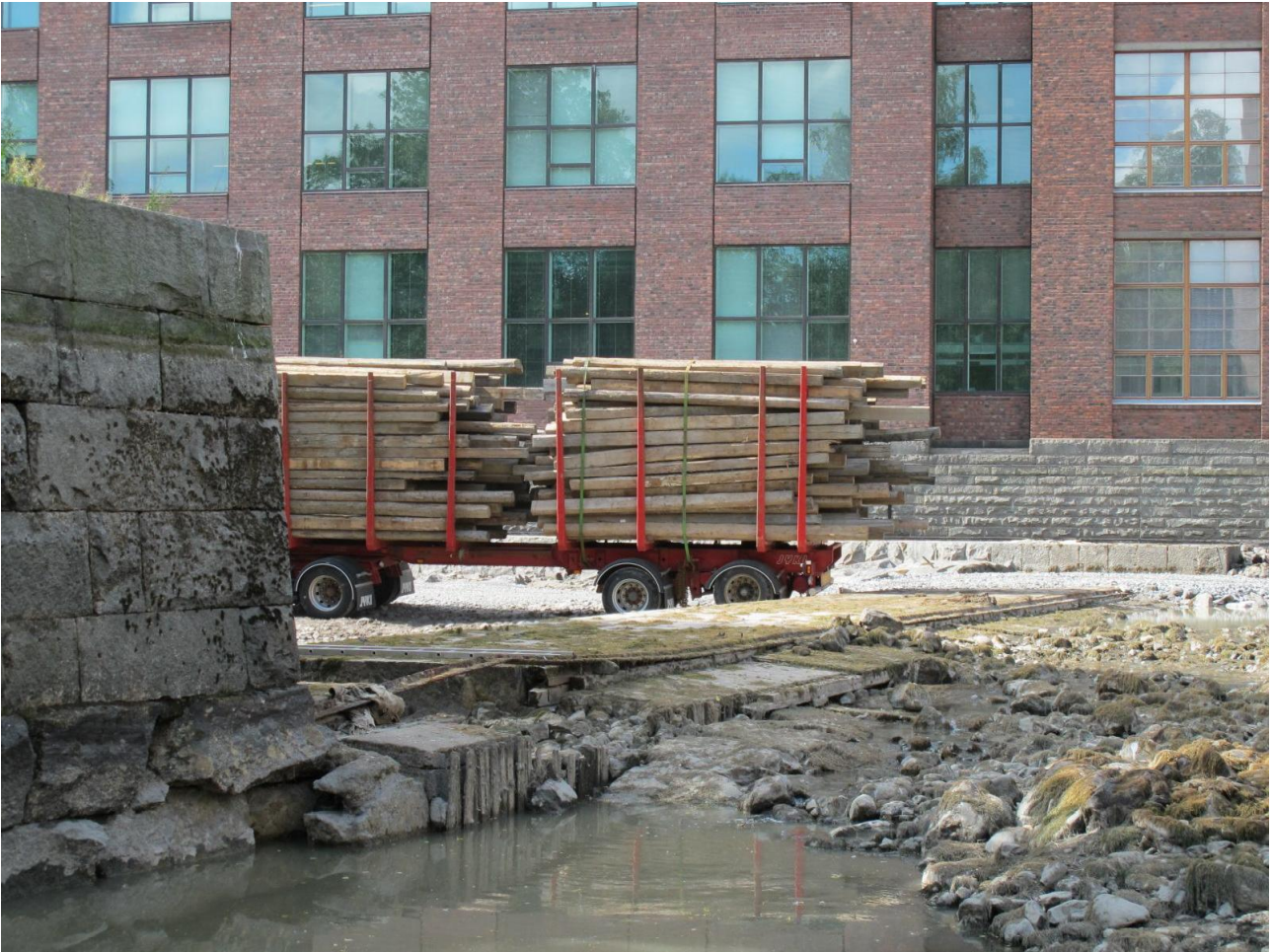
Konsulinsaaren pohjoispään kanavarakenteen kansi. Hannele Kuitunen
