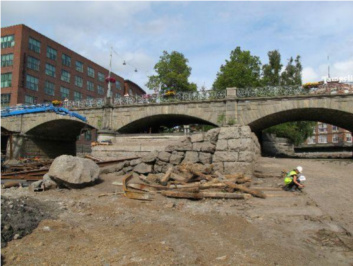
Kivirakenne Satakunnan sillan eteläkylki etelästä. Hannele Kuitunen
