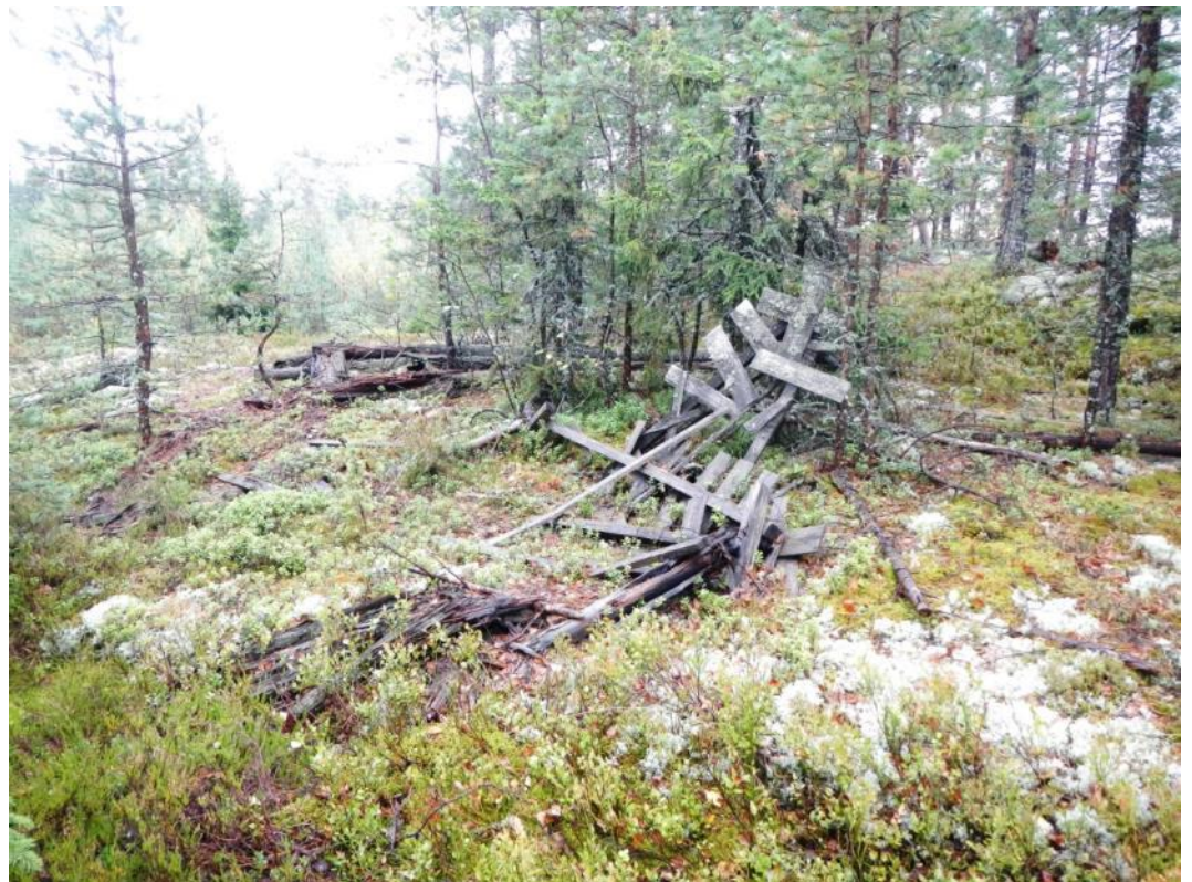
Kuva 3. Merivuoren laella sijaitsevan mittaustornin jäännökset.
