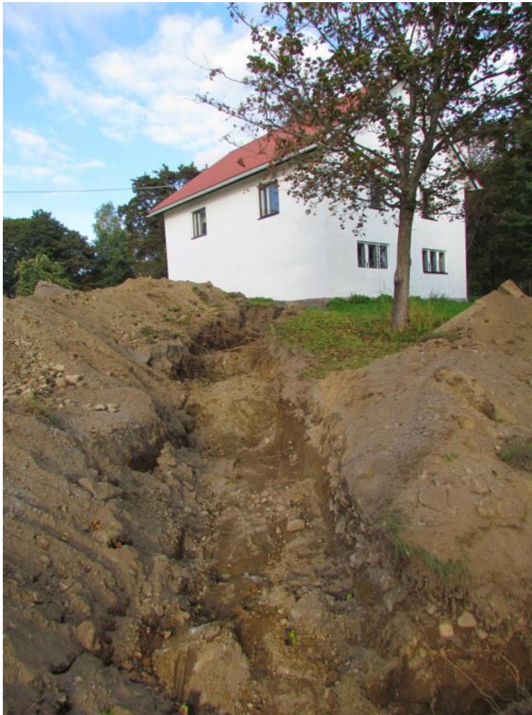
Kuva 8. Pehtoorin talolle johtava kaivanto. Kallio on paikoittain hyvin lähellä maanpintaa. 18.9.2014.
