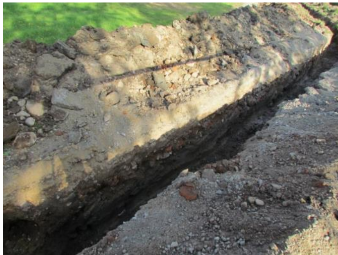
Kuva 4. Kaivettua ojaa Viljamakasiinin länsipuolella pihatien kohdalla. 18.9.2014.
