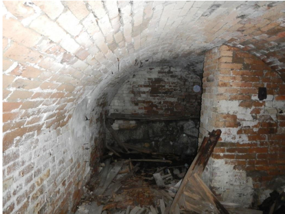
Kuva 18. Pehtoorintalon kellarin sisätiloja.
