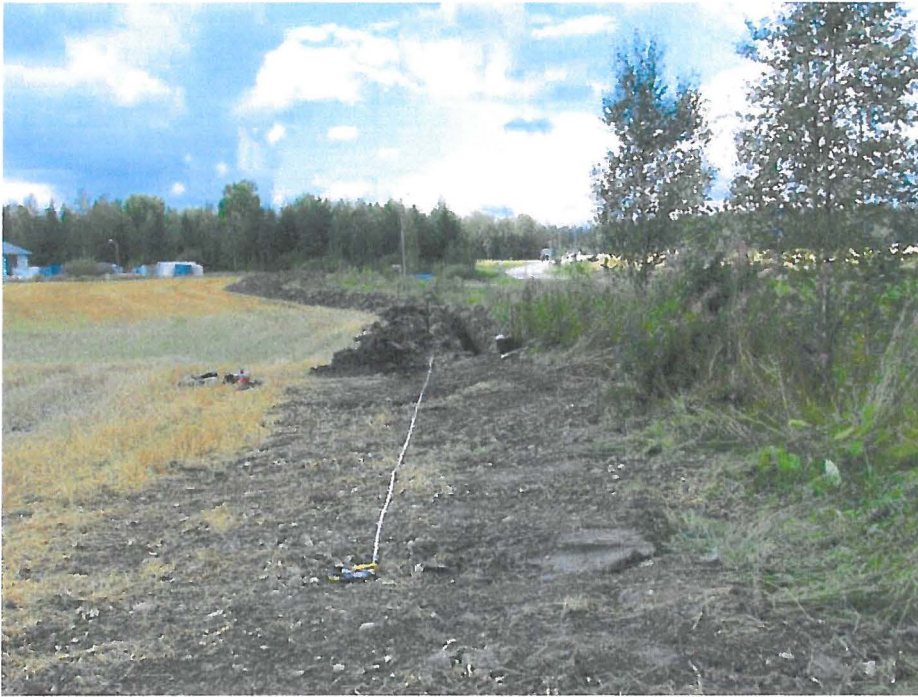
Kuva 6. Mittanauhan osoittamalla alueella oli kaapelikaivannon täyttömaassa havaittavissa so- raa. Kuvattu koillisesta. (Kuva: Vesilahti dokumentointi 2014: 2)
