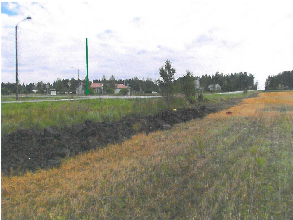
Kuva 5. Etualalla avoinna oleva ja takana jo peitetty maakaapelikaivanto Vesilahdentien eteläpuolella, lähellä Vesilahdentien risteystä. Rautiantien ja vesilahdentien risteys merkitty kuvaan nuolella. Kuvattu lounaasta. (Kuva: Vesilahti dokumentointi 2014: 1)
