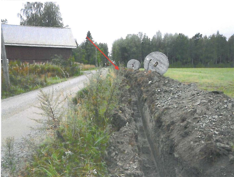
Kuva 22. Kaapelikaivanto Vahderpääntien koillisreunassa. Havaintokohta 1 merkitty kuvaan nuolella. Kuvattu kaakosta. (Kuva: Kangasala Huutijärvi – Pispala 2014: 23)
