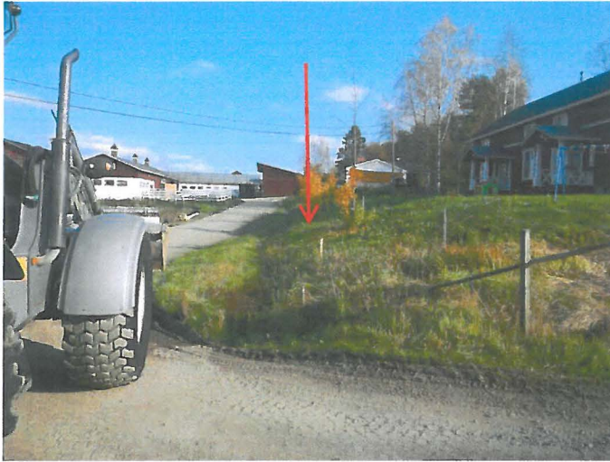
Kuva 4. Suomatkan kylätontin pohjoisosassa kulkevan kaapelikaivannon alue. Kuvattu länsilounaasta. (Kuva: Kangasala Huutijärvi – Pispala 2014: 4)
