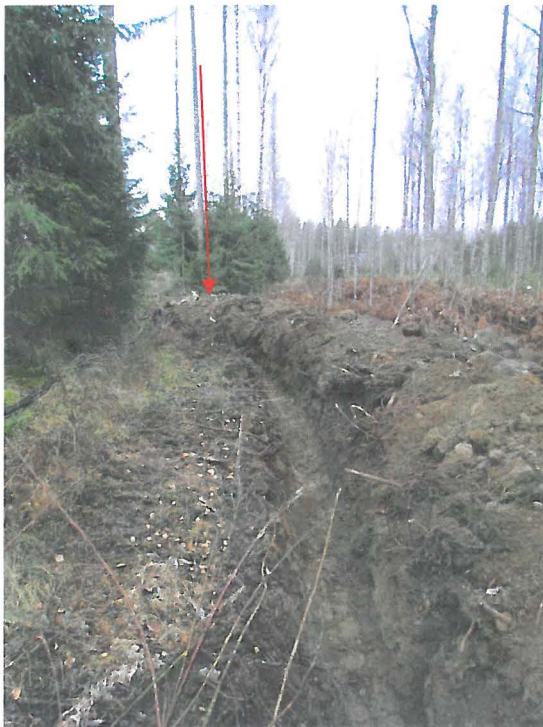
Kuva 13. Valmiiksi kaivettu kaapelikaivanto. kohta, jossa kaivanto ylittää historiallisen tien ja jossa oli havaittavissa vähäisiä merkkejä historiallisista tiekerroksista on merkitty kuvaan nuolella. Kuvattu pohjoiskoillisesta. (Kuva: Kangasala Huutijärvi – Pispala 2014: 14)
