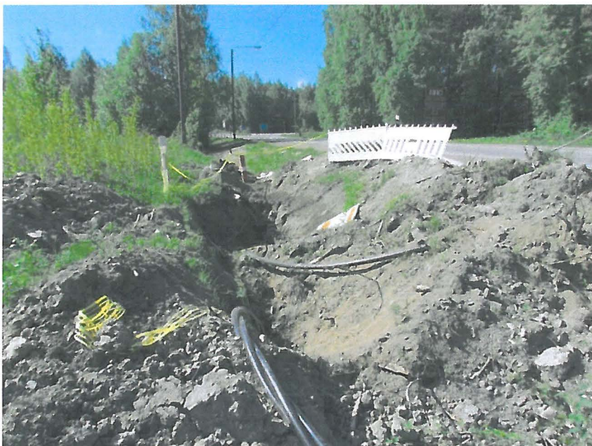
Kuva 1. Tutkimusalue Ponsantien itäpuolella dokumentointia aloitettaessa. Tienpiennar on luiskattu ja kaapelit asennettu kuoppaan.
