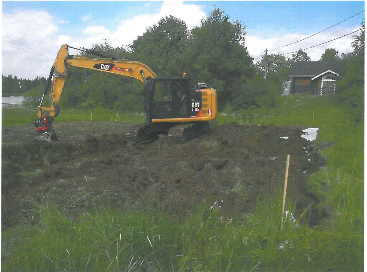
Kuva 9. Kuoritun alueen päälle levitettiin suodatinkangas ja alue peitettiin koneellisesti. Kuvattu etelästä.
