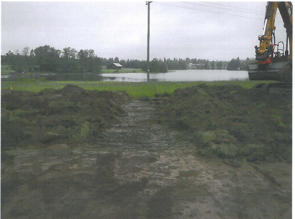
Kuva 2. Kuoritun alueen länsireunalle kaivettu koeoja, pohjasaveen asti kaivettuna. kuvattu kaakosta.
