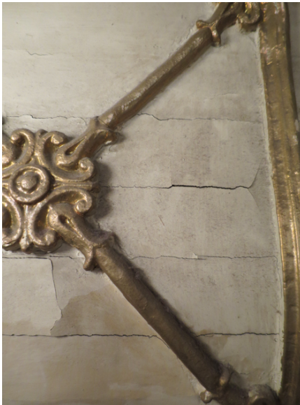
2. parvikaiteessa näkyy maali-irtomaa laudoituksen suuntaisesti. Puuta vasten olevan kankaan on alkuperäisesti ollut tarkoitus pitää maalipinnat ehyinä, jotta välttyään vastaavanlaiselta tilanteelta. Paksut kittikerrokset edesauttavat halkeilua.
