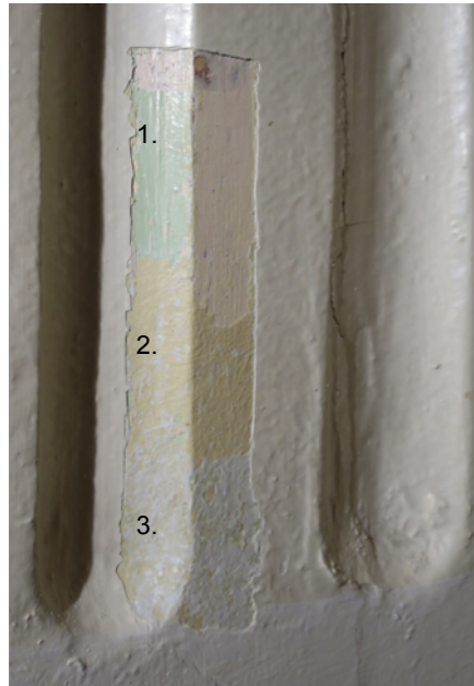
Pilarin kanneluurin väriportaikon kolme alinta maalauskerrostumaa. Pilarin alaosa on nykyisen huoltomaalauksen jäljiltä lateksimaalia, pilarin yläosa (kanneluureista alkaen) edellisen maalauskerrostuman alkyydimaalia.
