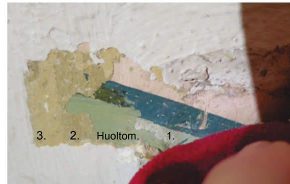
Parvikaiteen juuresta paljastuneeseen koskemattomaan 1879 pinnan viereen esiinnotetu muut maalikerrokset.
