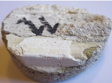
Näyte pohjapuolelta. Näytteen nurkkaan oli jäänyt vanhoja maalikerroksia uudemman rappauksen alle. Näytekoon ollessa näin pieni, ei tarkkaa kerrosasettelua voinut tehdä.
