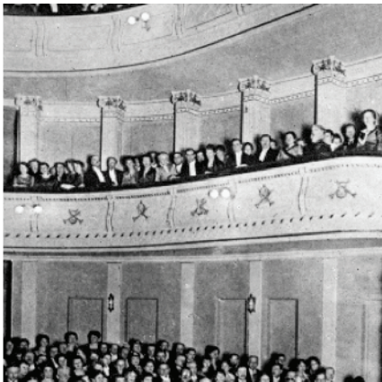
Varhaisin valokuva katsomosta vuodelta 1919. Seinäpinnat ovat huomattavasti tummemmat pilareihin ja seinän friisiin verrattuna. Parvikaiteet vaikuttavat myöskin hyvin vaaleilta, vaikka sävykoodauksen mukaan parvikaiteiden hakkuripinta on sama kuin seinien.
