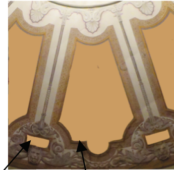
Kuvamanipulaatioon on lisätty vaalealla ruskealla värillä alueet, joihin on myöhemmässä korjausvaiheessa lisätty paperointi.
