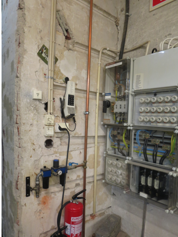
Mahdollisesti vuoden 1909 maalauskerrostumaa pilkottaa nykyisen kalkkauksen alta.
