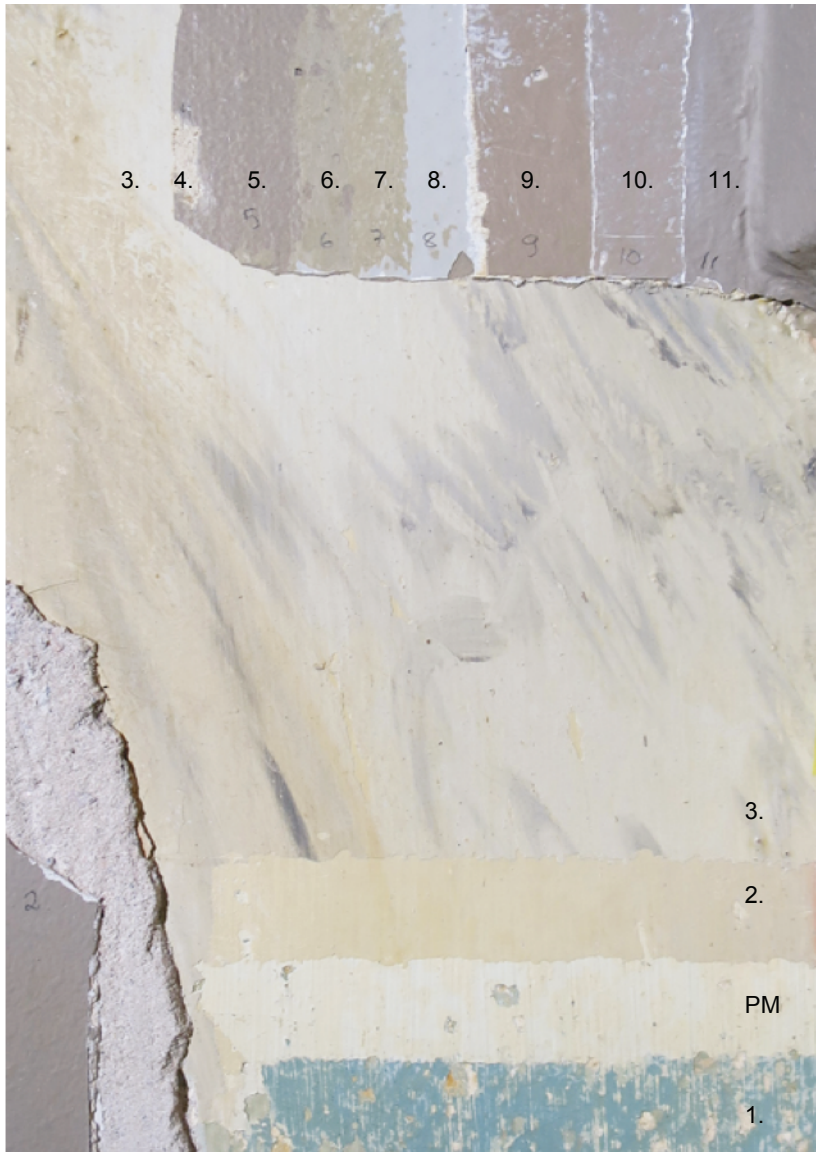
Päälämpiön seinän pitkän alanelin väriportaikko. Neljäs maalauskerrostuma tässä esiinotossa vain fragmentaarisesti esillä. Muualta maalauskerros tuli paremmin esille ja sävykoodi saatiin luotettavasti otettua.
