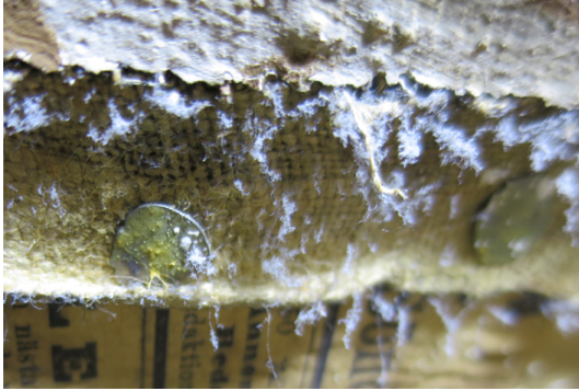
Kangas on kiinnitetty leveäkantaisilla "huopanauloilla" kattoon.
