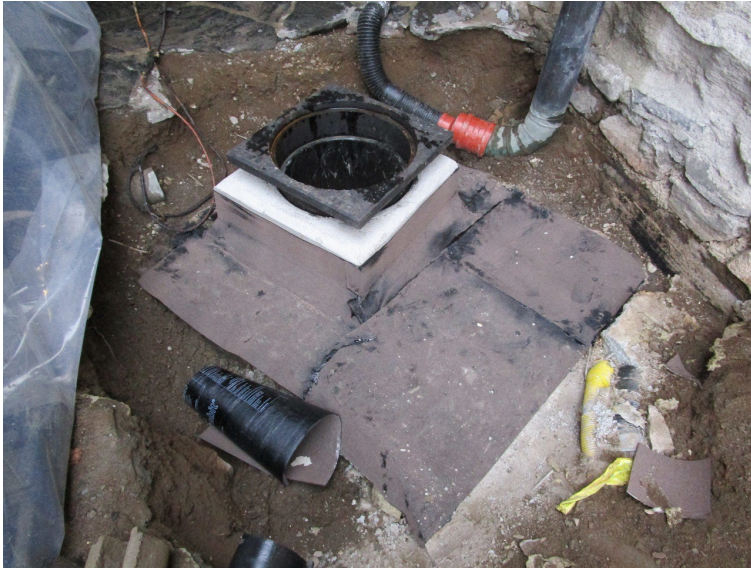
KUVA 5. Kanavalle valettiin uusi kaulus ja sen pinta vesieristettiin bitumikermillä. Kuva: Tuija Väli-Torala, Kivityö Kaseva Oy.
