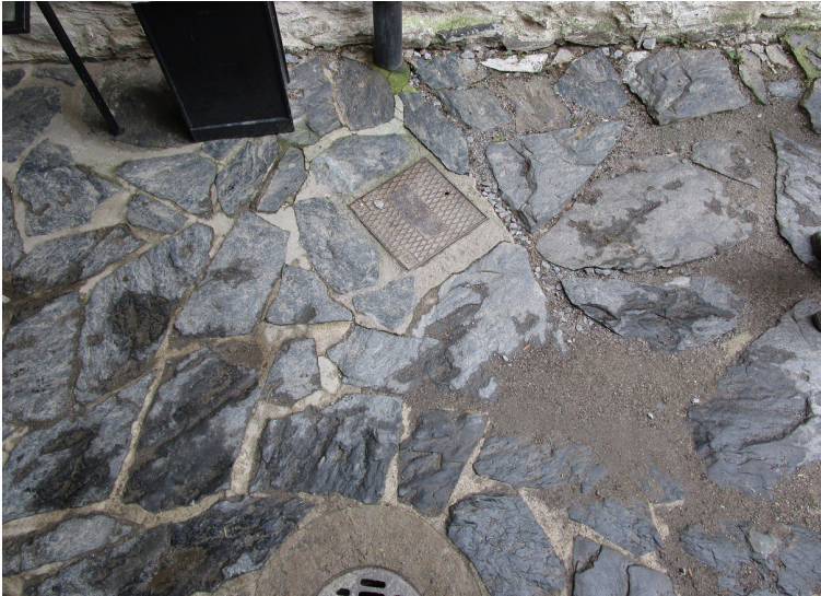
KUVA 2. Kaapelikanavan kansi kuvassa liuskekivien ympäröimänä. Kuvan alareunassa näkyy sadevesikaivo. Kuva: Tuija Väli-Torala, Kivityö Kaseva Oy.
