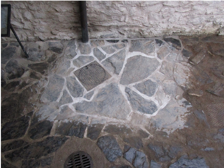
KUVA 6. Pintakivet on aseteltu alkuperäisille paikoilleen ja saumattu kiinni. Kuva: Tuija Väli-Torala, Kivityö Kaseva Oy.
