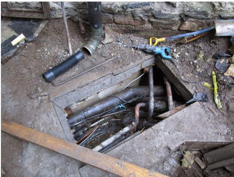
KUVA 4. Kanava avattiin putkitöitä varten. Kuva: Tuija Väli-Torala, Kivityö Kaseva Oy.
