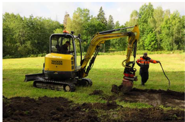
5. Työkuvaa. Kaivinkone poistaa peltomultaa ojassa 1. Ulrika Rosendahl valvoo. E-W. 20.8.2014. MH.
