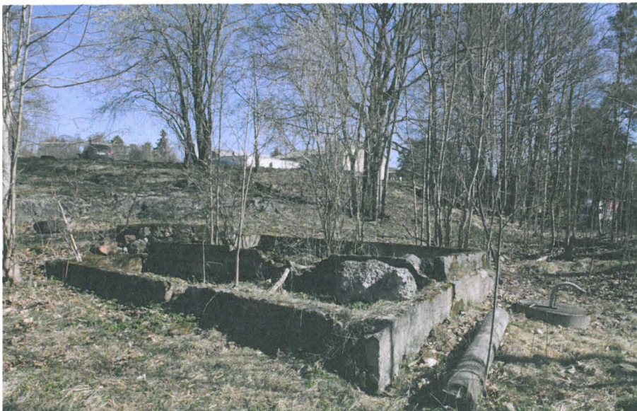
← Ylempänä rinteellä polun vieressä sijaitseva betonista valettu kivijalka.
