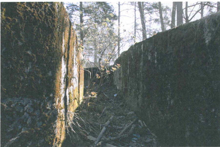
← Osa haudoista on tutettu betonilla.
