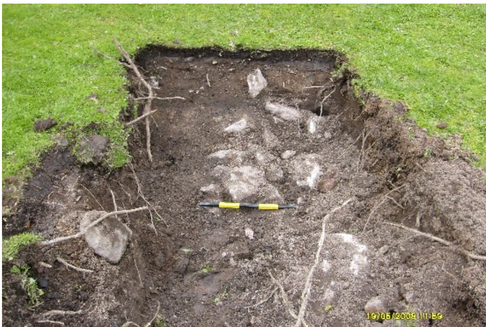
Kuva 11: Varsinaisia kivrakenteita ei puistotöiden yhteydessä tavattu. Niin kuopasta n:o 35 (kuva) kuin Eteläpuistokadunsivustan kuopista n:o 38-49 löytynyt kiviaines on tulkittavissa alueelle tarkoituksella tuoduksi tasoitteeksi ja täytteeksi. E. Kuva KyM/M. Kykyri.
