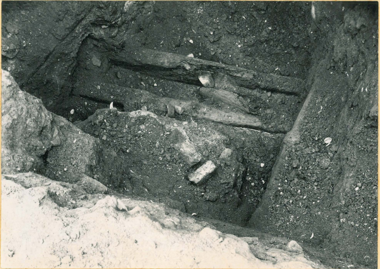
Kuva 5. Vanhan Brahenkadun alta löydetty muuri, joka todennäköisesti on kirkon länsipäätyä. Muuri näkyy keskellä; se on katkaistu jo silloin kun kadun alle pantiin kadun suunnassa kulkeva puinen kuurna. - Valok. Welin.
