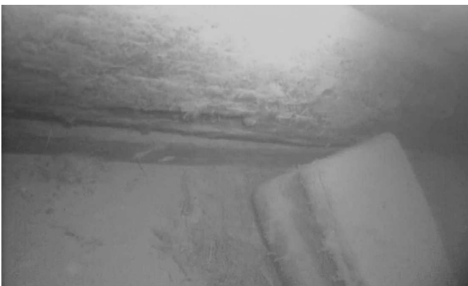
Kuva 17. Kuvakaappaus videolta kohteesta 3. Kuvassa näkyy toisiinsa päällekkäin liitetyt lankut ja hirsi sekä painekyllästetty, pontattu hirsi.
