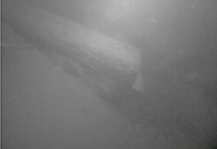
Kuva 13. Kuvakaappaus viedolta kohteesta 2. Veistetyssä hirressä on päässä liitos. Hirsi makaa salvoksesta rauenneena pohjassa. Hirren läheisyydessä sijaitsee pohjasta pystyssä oleva hirsi, jonka liitoksesta se ilmeisesti on irronnut.
