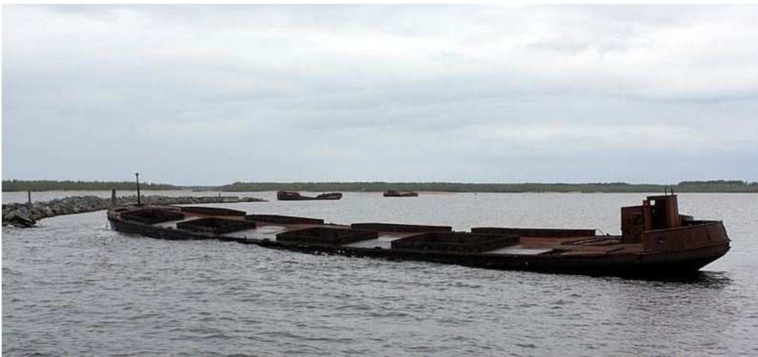
Kuva 3. Tukkialtaan edustalle, Kiusalanniemen pohjoispuolelle upotetut proomut. Louheesta tehty aallonmurtaja näkyy kuvassa proomujen välissä. Kuvälähde:
