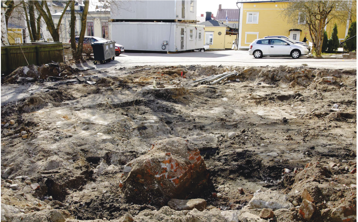
Kuva 2. Yleiskuva alueesta 1 pintamaan poiston jälkeen. Etualalla lämpökeskuksen raunioita, taustalla profiilista työntyvät esiin lämpöputket. Kuvan keskellä erottuva punainen paalu on uudisrakennuksen nurkan paikka. SKDG201401:9.
