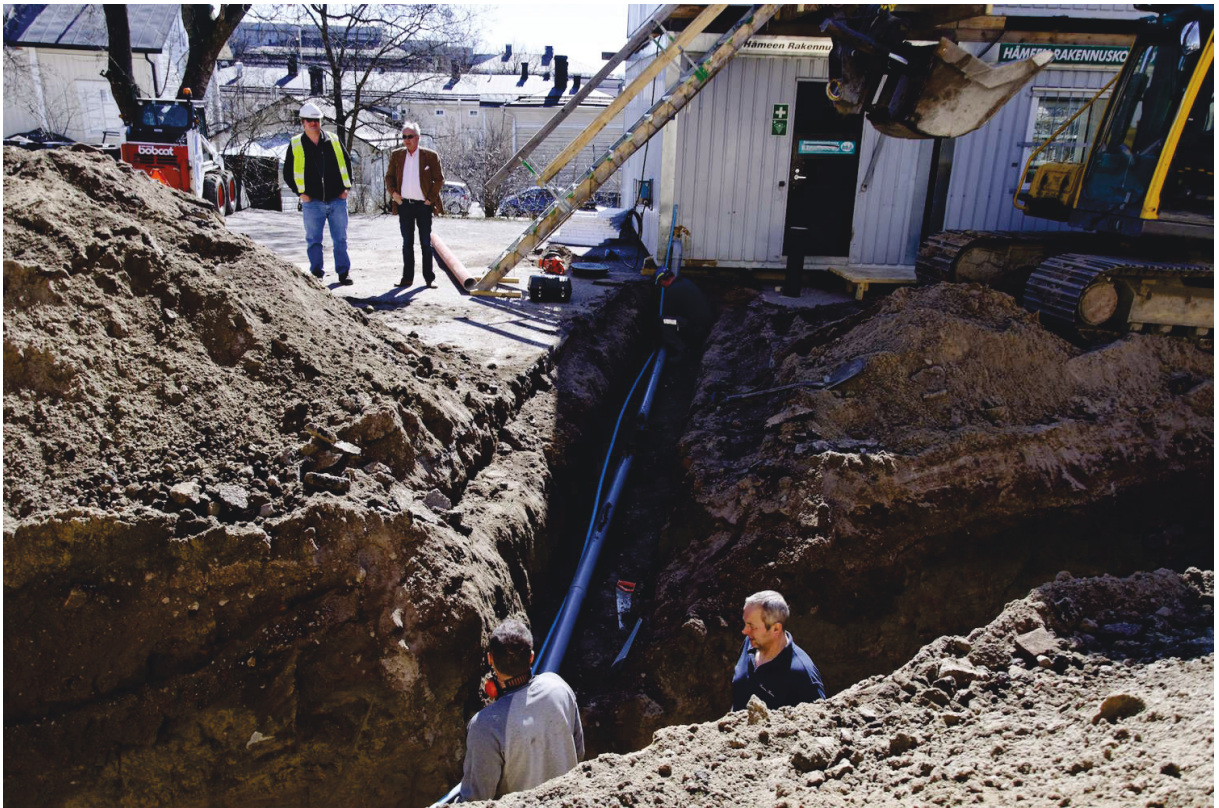
Kuva 6. Alueen 2 eli putkikaivannon eteläprofiilissa näkyvä vahva viljelykerros lienee perua vanhemmas- ta maanviljelystä ennen kaupungin levittäytymistä nykyiselle alueelle. Kuvassa näkyvän pistokaivannon oikealla puolella tumman kerroksen M202 päällä oli jonkin verran lahonnutta puuta, mutta jäännökset eivät ilmeisesti kuulu mihinkään rakenteeseen. SKDG201401:35.
