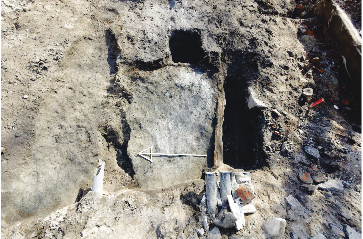
Kuva 5. Alue 1 pohjaan kaivettuna. Syvän kaivannon L117 pohjalla erottuvat valurautaiset putket, kaivannon reunassa on tukilautoituksen jäännös. Harmaa kerros keskellä on luontainen pohjasavi, punainen paalu oikealla merkitsee uudisrakennuksen nurkkaa.
