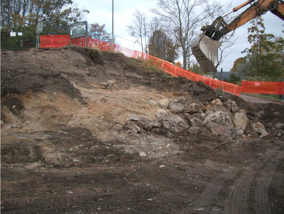
Hämeentie vierestä poistetaan saastuneita maita lisärakennuksen tieltä. Kuvaussuunta NW. Kuva: HKM.
