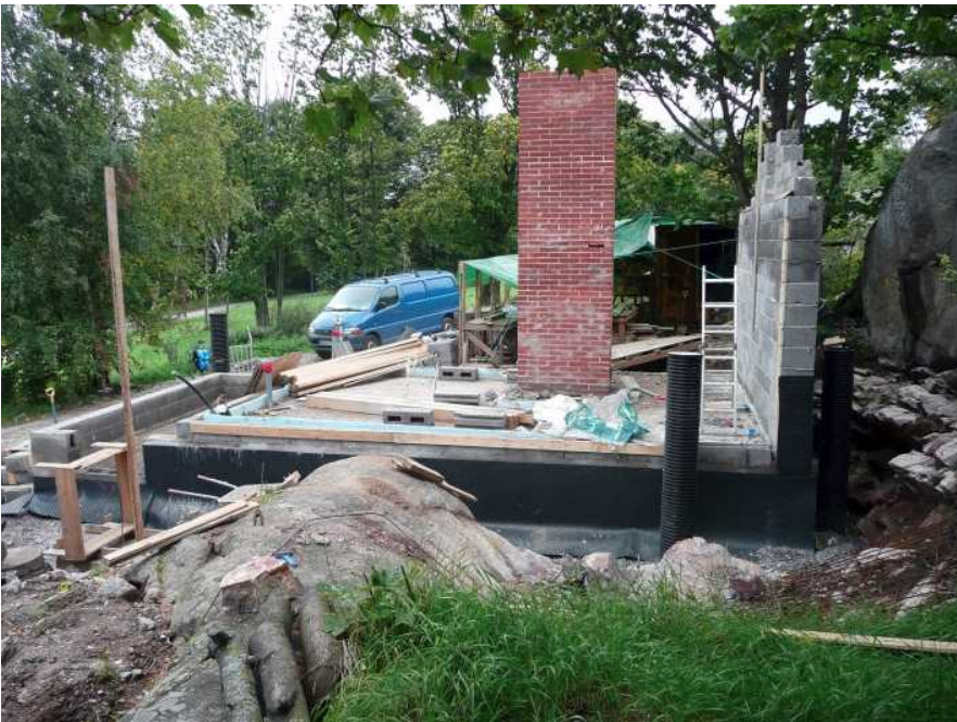
Uusi ulkorakennus on valmistumassa. Kalliota on jouduttu louhimaan rakennuksen kohdalta. Kuvaussuunta NW. (Kuva: HKM/Vanhakaupunki 2008:6).
