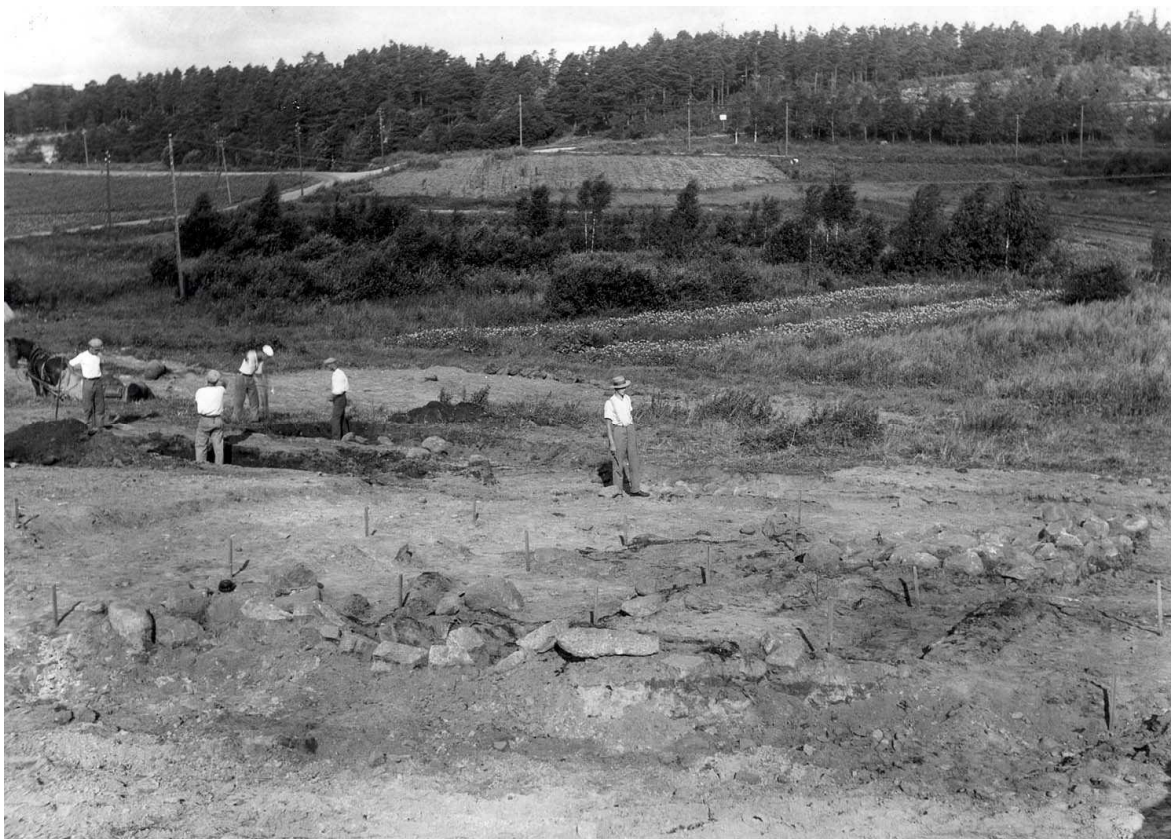
Yleiskuva Kellomäen pohjoisrinteestä kaivausten aikana vuonna 1930. Kuvan keskellä olevan metsikön kohdalla menee nykyisin Lahdentie. Kuvaussuunta NW. Kuva: HKM.
