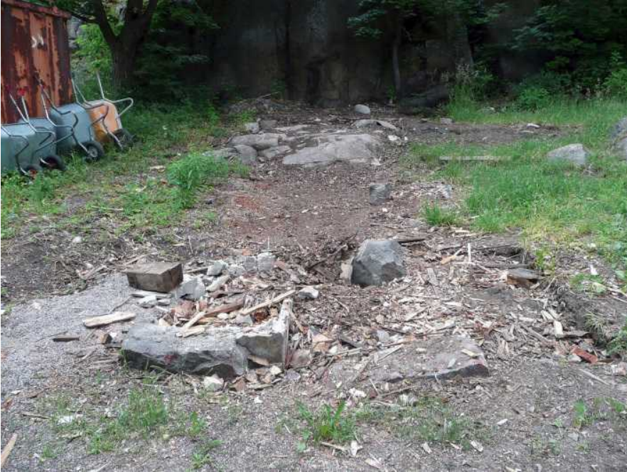
Vanhan ulkorakennuksen länsisiipi on purettu. Kuvaussuunta NE. 17.6.2008. (Kuva: HKM/Vanhakaupunki 2008:4).
