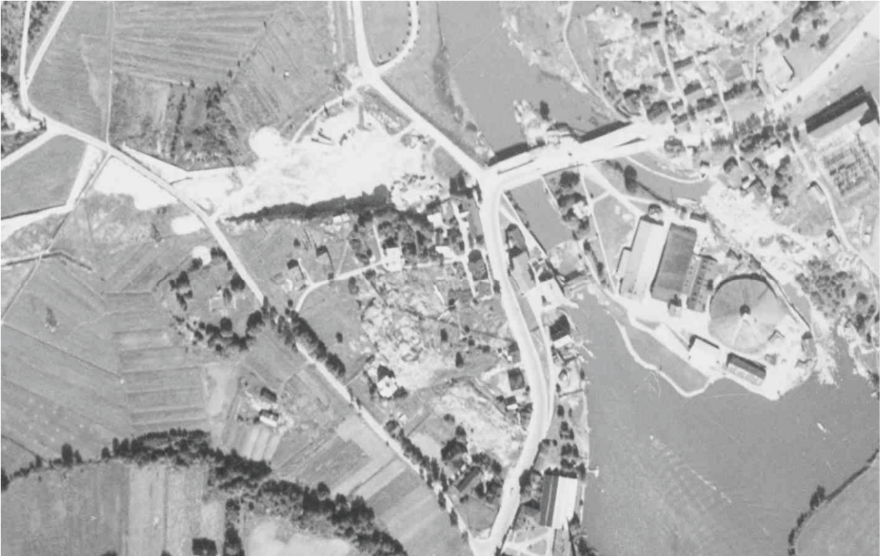
Ilmakuva vuodelta 1932. Koskelantien tietyömaa on vielä kesken ja mäen pohjoisosa on kokonaan työmaata. Uudelle vedenpuhdistuslaitokselle johtava tie ja sen länsipuolella 1926 laitetut vesiputkikaivanto näkyvät lähempänä jokea. Vanhankaupunginkoskessa näkyvät yhä vanhat sillat uusien vieressä. Länsikosken uusi silta on rakennettu 1926 ja itäkosken silta on valmistunut 1933/34. Viikin puolella näkyy Viikintien vanha linjaus. Nykyisen tien kohdalla on vielä rakennuksia. Kellomäen huipun 1. maailmansodan aikaiset linnoitteet on ilmeisesti peitetty. Kuva HKM.
