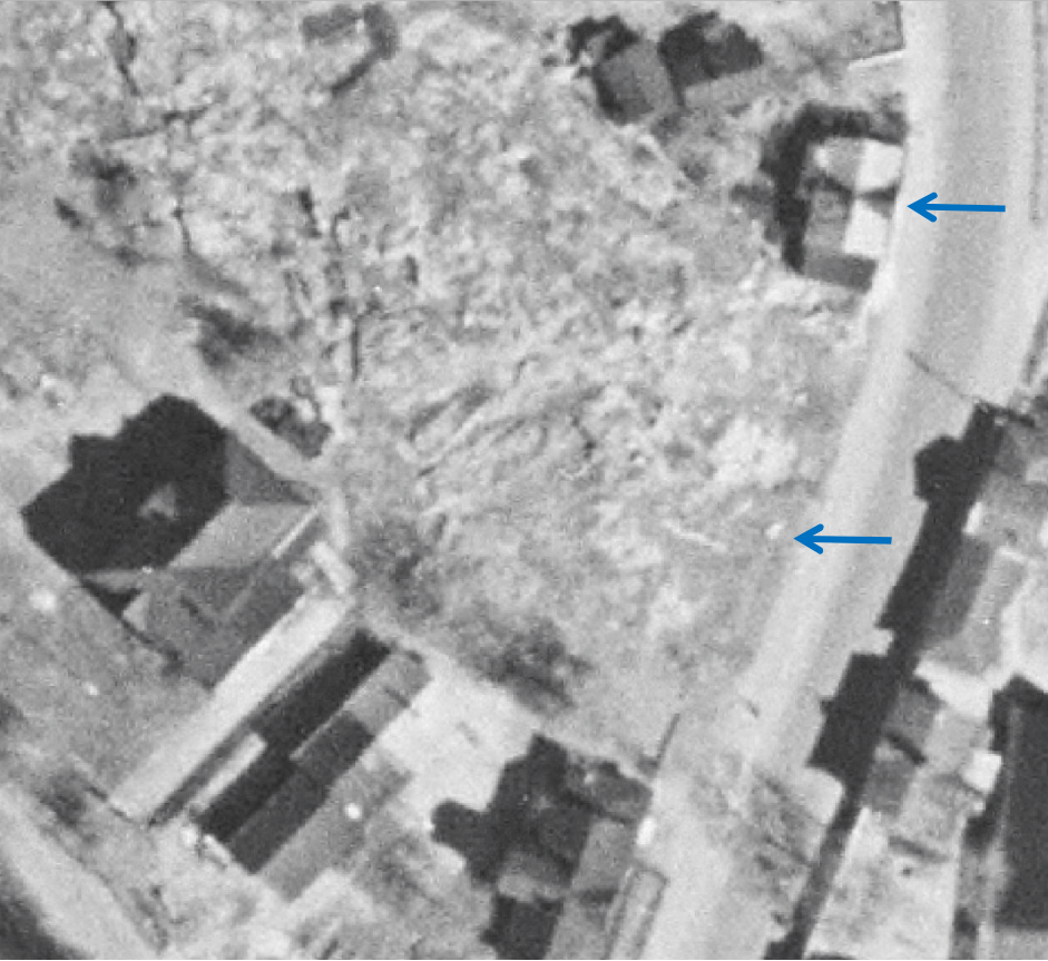
Ilmakuva vuodelta 1943 Kellomäki 2009:n alueesta. Hämeentie 168:ssä ei sijaitse rakennuksia. Hämeentie 170:ssä on vielä 1950/1960-luvun taitteessa purettu rakennus. Kuva: Helsingin kaupunki.
