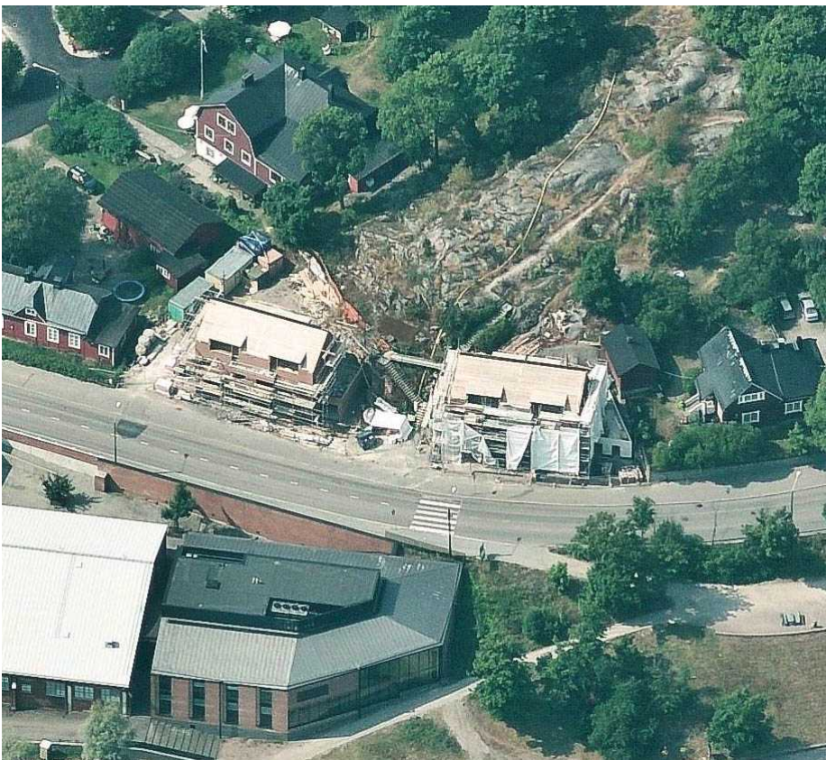
Kopterikuva Kellomäki 2009:sta uusien talojen rakennusvaiheessa. Kuvaussuunta W. Kuva: Fonecta kartat, kopterikuvat.
