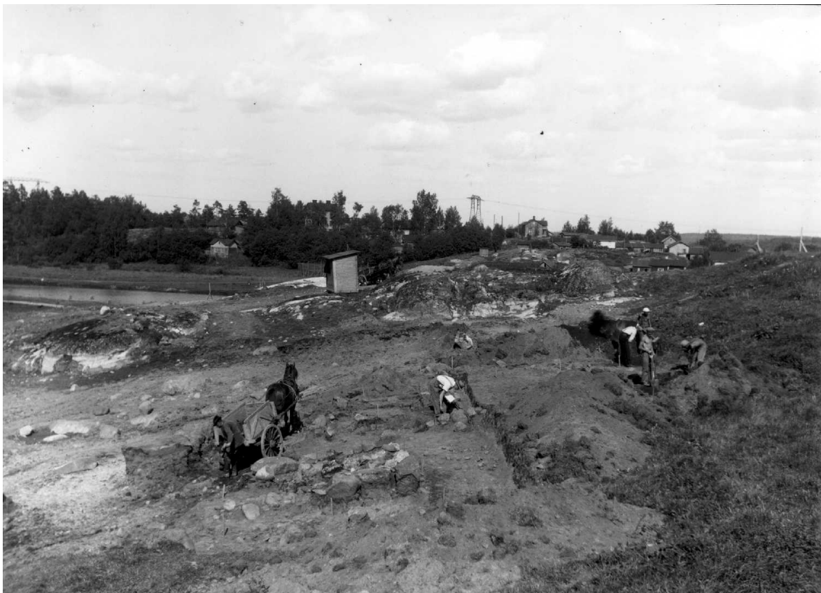
Kellomäen pohjoisrinteen kaivaus Koskelantien kohdalla vuonna 1930. Kuvassa näkyvät talonperustukset II-V. Kallion takana sijaitsevat perustukset I ja IX-X. Kuvaussuunta E. Kuva: HKM.
