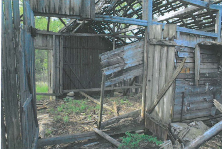
Sisäkuva ladosta/tallista. Rakenne on pystypaalujen varaan tehty yksinkertainen laudoitus. Huomaa rakennusosien uudelleen käyttö: oikealla alhaalla vanha ovi naulattu osaksi seinää vaakasuuntaan. Kuvan keskellä retkottavan oven aukko on ollut myös tukittuna, kuten laudoista voidaan havaita.
