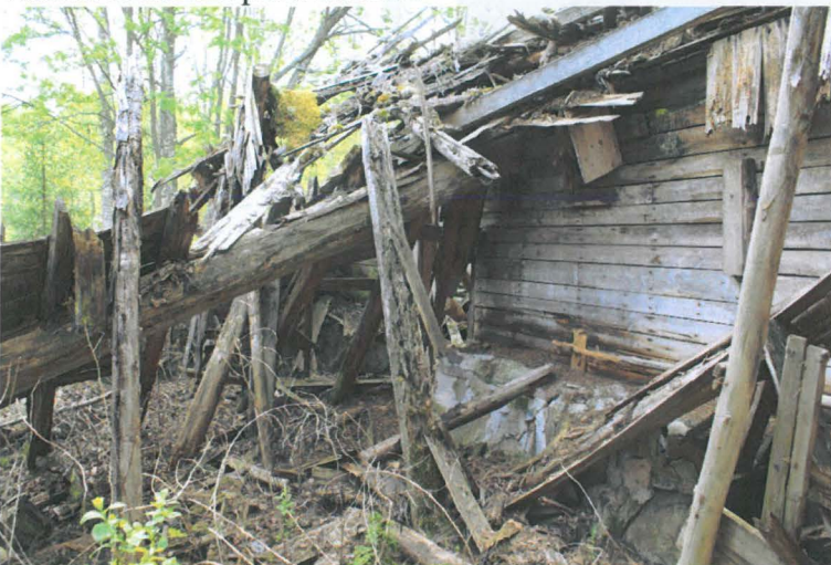
Yksityiskohtakuva rakennuksen sisältä. Kuva on otettu yleiskuvassa näkyvästä järven puoleisesta ikkuna-aukosta. Kivijalassa on aukko oven kohdalla ja sisäpuolen lattia on ollut maantasossa.
