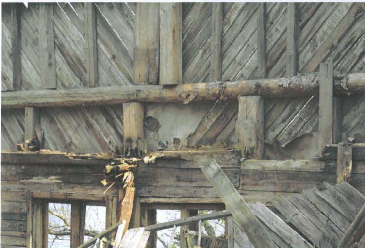
Yksityiskohtakuva rakenteista. Pystypaalujen varaan tehty laudoitus. Ulkoseinässä tuulensuojapahvi ja laudoitusten välissä eristeenä puru tai olki.
