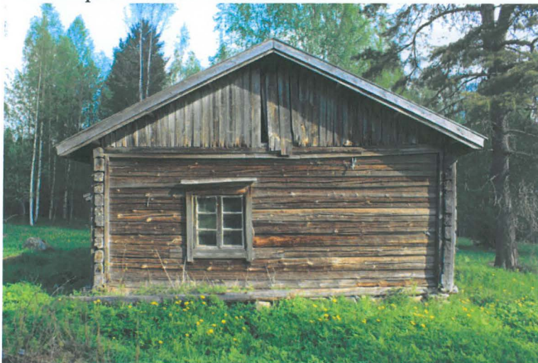
Anttilan päärakennus etelästä
