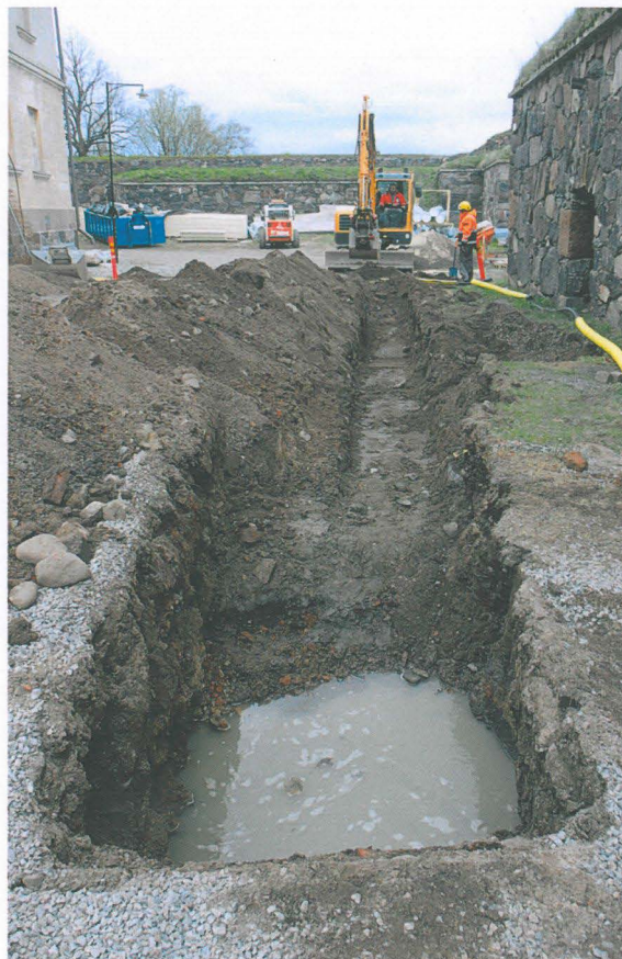
Kaivanto kuvattuna etelästä.
