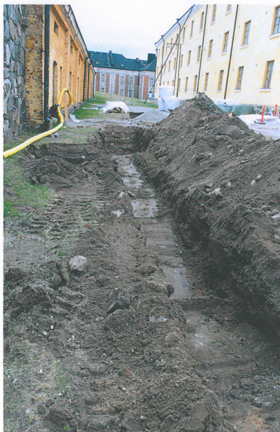
Kaivanto kuvattuna pohjoisesta.
