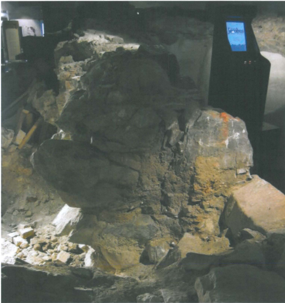
Kuva 3. Kuva 3 on otettu kuvassa 2 vasemmalle jäävästä kellarin seinämuurista. Kuvassa näkyy seinän yläosan rakenteen poikkileikkaus. Seinä on muurattu lähes kokonaan isoista luonnonkivistä ja siinä vaikuttaa olevan täytteenä erittäin haurasta laastia ja hiekkaa. Mikäli tämä "hiekkasydän" on ainoa muurin sisärakenne, on mahdollista että muuri repeää ja halkeaa kahtia. Mikäli näin käy, muurin vasen puoli (kuvassa) sortuu kaivausalueelle. Katso myös kuva 4, joka selventää muurin rakennetta.
