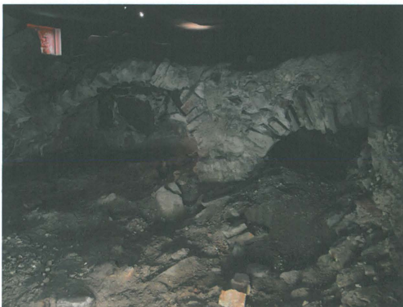
Kuva 7. Holvikomerot R23:1 (vas.) ja R23:2 lounaaseen. I. Aalto. AKDG3276:102.
